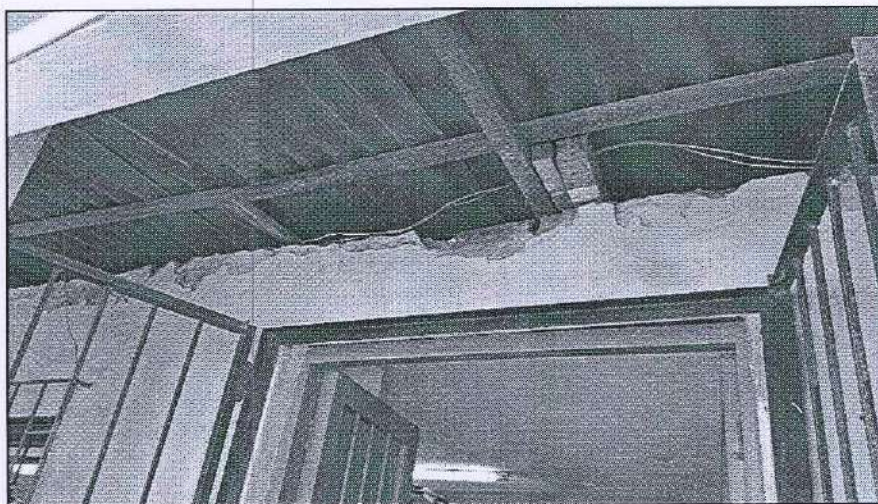
IMAGEN 05: Se observa la construcción de adobe en condiciones precarias, al igual que la cobertura.
