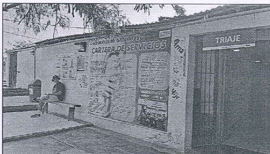
IMAGEN 02: Se observa que las paredes de adobe presentan fisuras y rajaduras por el mal estado y la presencia de humedad en la parte inferior generan fallas estructurales.
