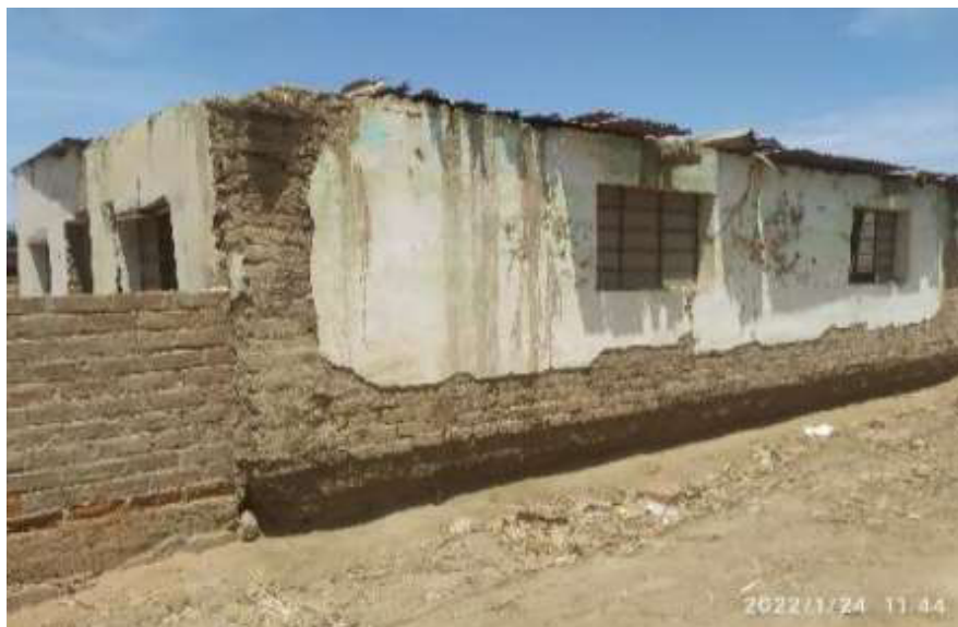
Foto N°4: El depósito de adobe que presenta daños estructurales, se recomienda su demolición.
