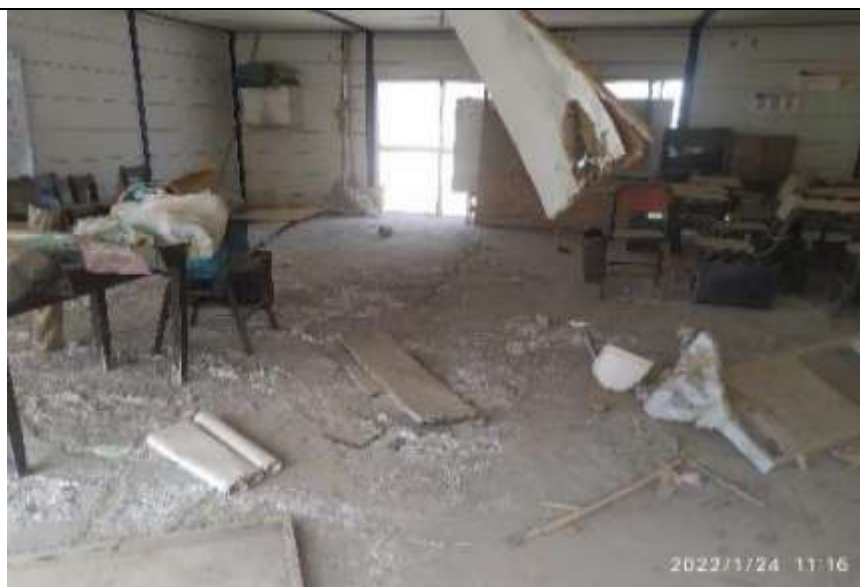
Foto N°6: Interior de modulo pré-fabricado, el falso techo en mal estado.
