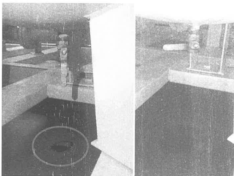
Fotografía N° 11. Salida de aceite del tanque de aire comprimido
