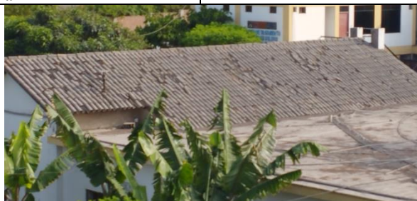
Foto N° 05. Teja en mal estado
