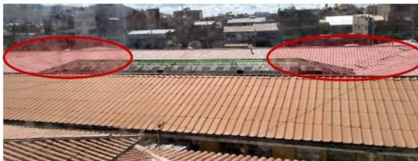
Imagen 03: teja Residencial, se encuentran mal colocadas, deterioradas
