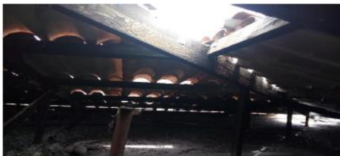
Imagen 05: no existe empalme correcto o sellado entre las piezas de teja y losa de concreto
