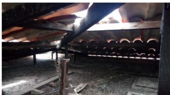
Imagen 04, losa de concreta cubierta en su totalidad por fecas de paloma
