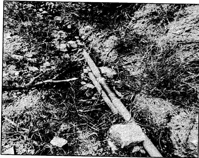
Figura 3 Tubería de línea de conducción expuesta a la intemperie, con parches
