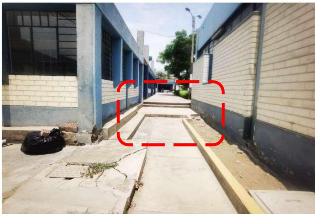
Fotografía N° 05.- Vista de Rampa N°05 cuenta con un desnivel y no existe rampa para el desnivel, se propone una rampa de 10%.
