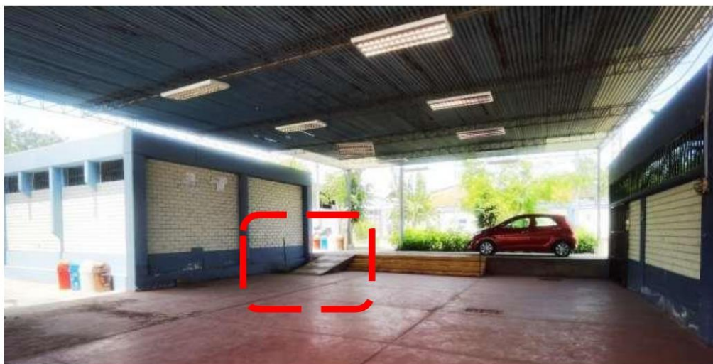
Fotografía N° 09.- Vista de Rampa N°09 cuenta con una rampa que no cumple con la normativa vigente, en cuanto a barandas pendiente y dimensiones reglamentarias.
