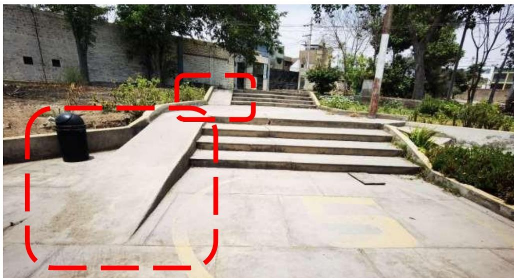
Fotografía N° 01.- Vista de Rampa N°01 cuenta con una rampa que no cumple con la normativa vigente, en cuanto a pendiente, barandas y dimensiones reglamentarias.
