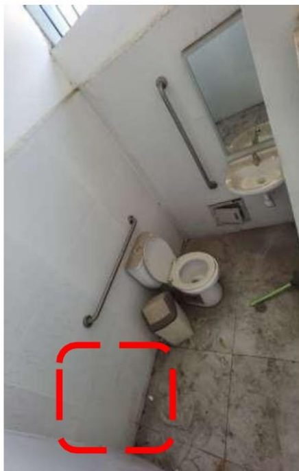
Fotografía N° 10.- Vista de los baños existentes, deben contar con las medidas mínimas para un giro de discapacitados y se ha replanteado en la nueva distribución.
