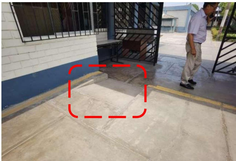
Fotografía N° 03.-, Vista de Rampa N°03 cuenta con una rampa que no cumple con la normativa vigente, en cuanto a pendiente y dimensiones reglamentarias.
