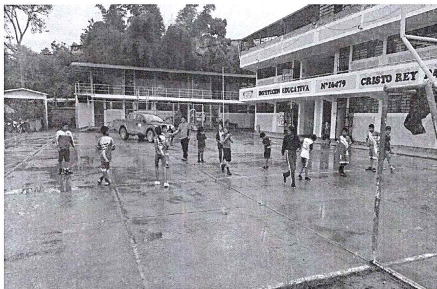
FOTO 20: Vista general de la losa deportiva en I. E. N° 16479 del Centro Poblado de Pacaypite, del distrito de la Coipa, donde se aprecia el deterioro del concreto por las constantes precipitaciones que caen en la zona.
