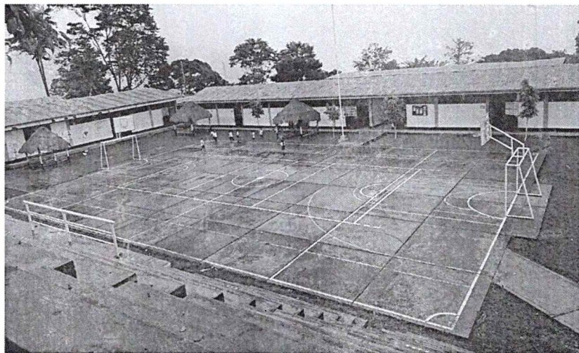
FOTO 06: Vista general de losa deportiva de la I. E. P. S. M. N° 16940 JOSÉ ANTONIO ENCINAS FRANCO, Centro Poblado San Pedro, del distrito de Namballe, donde se verifica el deterioro de la losa deportiva por las lluvias.
