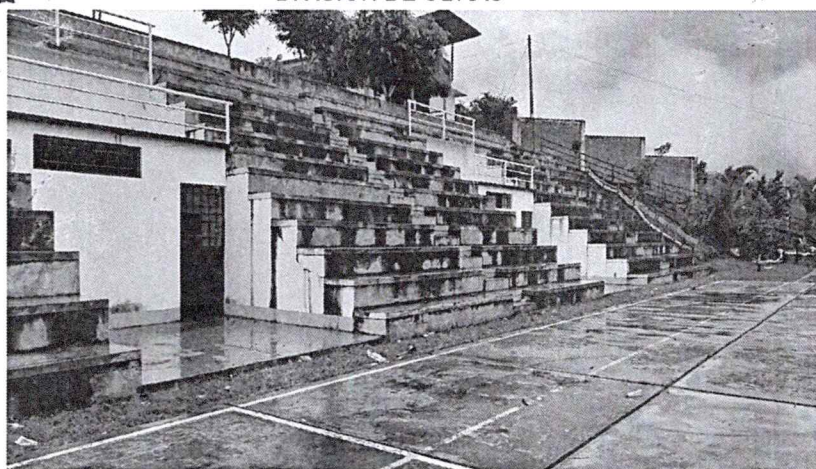
FOTO 07 Tribunas de losa deportiva de la I. E. P. S. M. N° 16940 JOSÉ ANTONIO ENCINAS FRANCO, Centro Poblado San Pedro, del distrito de Namballe, donde se aprecia el deterioro de las graderías por las constantes precipitaciones pluviales.
