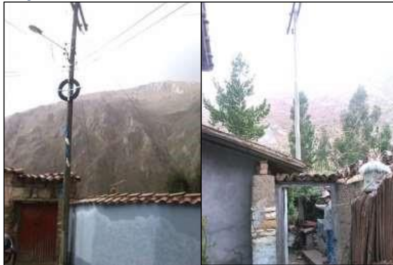
Fig. 3. Postes de madera de media tensión deteriorados
