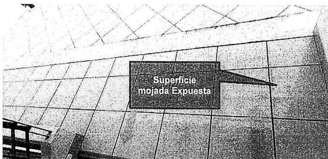
Imagen 11°. El pase de aguade lluvia por los costados de la claraboya principal, humedeciendo el piso por las escaleras y junta de construcción.
