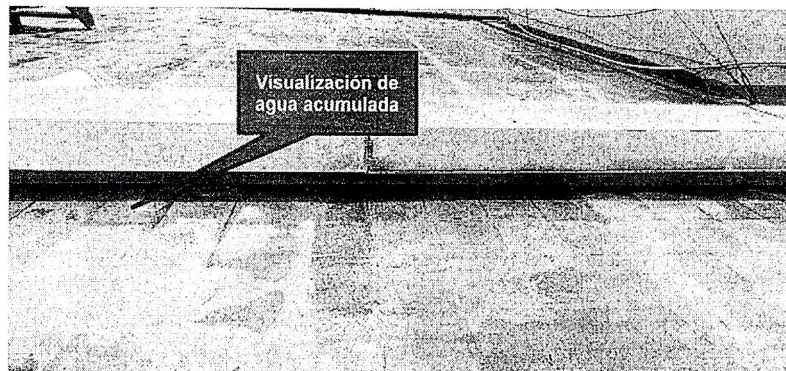
Imagenn°1. Acumulación y filtración de agua de lluvia por ocurrencias climatológicas
