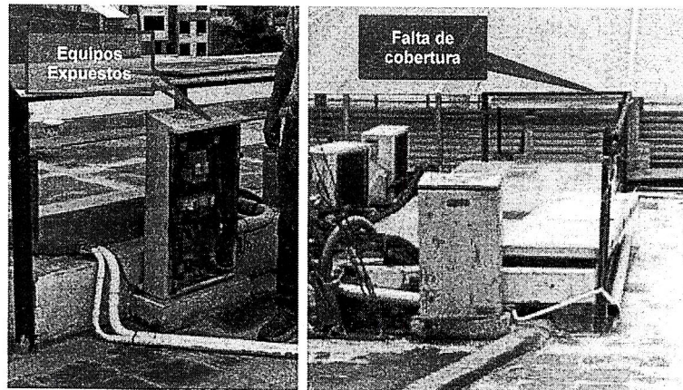
Imagen 15°. En mal estado las coberturas de los ductos, la cual deja a la intemperie de equipos e instalaciones eléctricas
