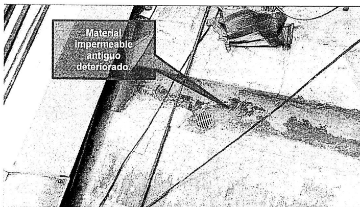
Imagen 20°. Canaletas en mal estado por falta de mantenimiento, material antiguo de impermeabilización, desprendido y obstruyendo el pase del agua para evacuación.
