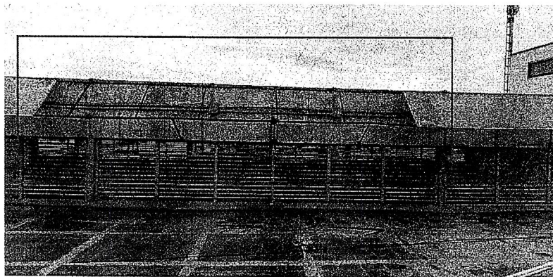
Imagen 6°. Deterioro, desgaste y sin elemento de protección casi total, en coberturas laterales de claraboya Principal, y deterioro y oxidación de estructuras metálicas.
