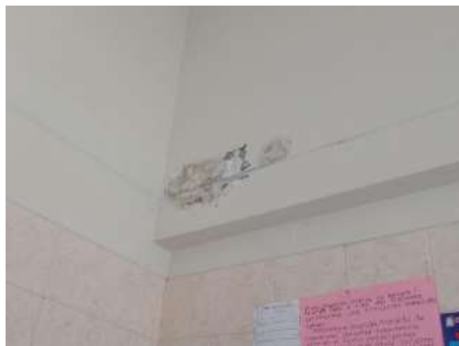
Vista donde se aprecia fisura en la pintura de la pared sobre el zócalo; causado por la humedad. Se plantea retiro del material exfoliado y repintado. Ambiente tóxico
