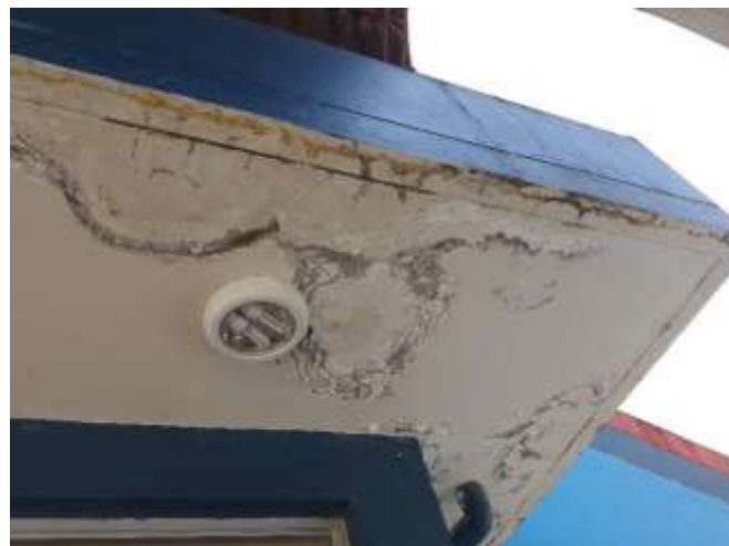
Vista del alero donde se aprecia fisuras y exfoliación de la pintura. Se plantea resane y repintado. Almacén central
