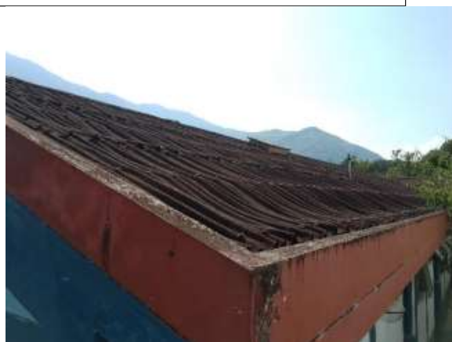
Vistan donde se aprecia filtración de la canaleta de concreto que causa exfoliación de la pintura. Se plantea tarrajeo con impermeabilizante y repintado.
