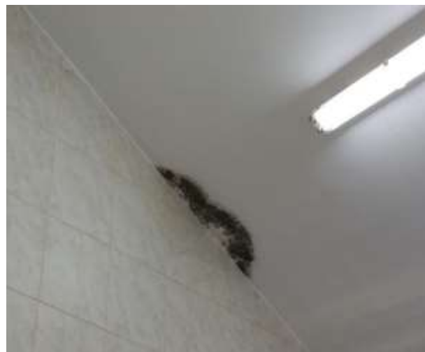
Vista de la mancha con moho en el cielo raso, causado por la húmeda, se plantea limpieza y repintado. Ambiente Farmacia
