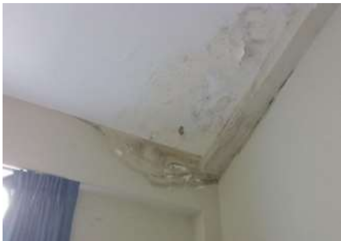
Vista de las manchas y exfoliación de las capas de pintura, causado por la humedad. Se plantea repintado. Ambiente Nutrición
