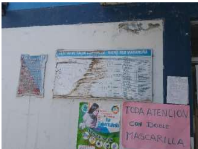
Vista del proceso de exfoliación de la pintura, causado por la humedad. Se plantea repintado. Facha principal
