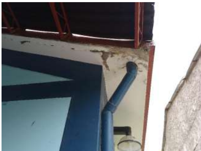
Vista del alero frontal donde se aprecia la exfoliación de la pintura. Se plantea repintado. Residencia de medicina.
