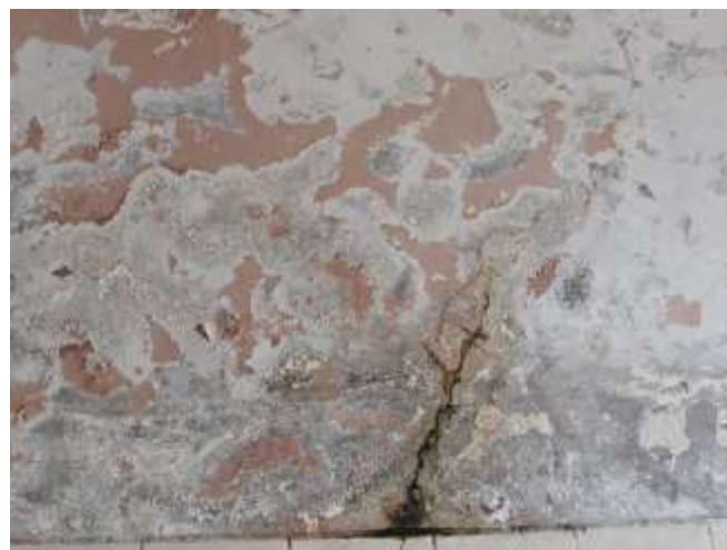
Vista que detalla el proceso de exfoliación de la pintura y fisuras. Se plantea resane y repintado. 2do corredor longitudinal
