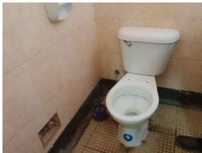
Vista de la base del inodoro con filtración. Se plantea cambio del anillo de cera. Baño del consultorio de medicina
