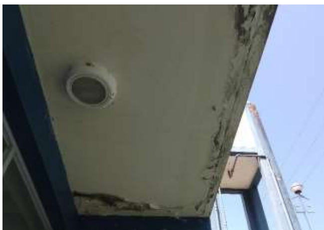
Vista del alero donde se aprecia fisuras y exfoliación de la pintura. Se plantea resane y repintado. Facha principal.
