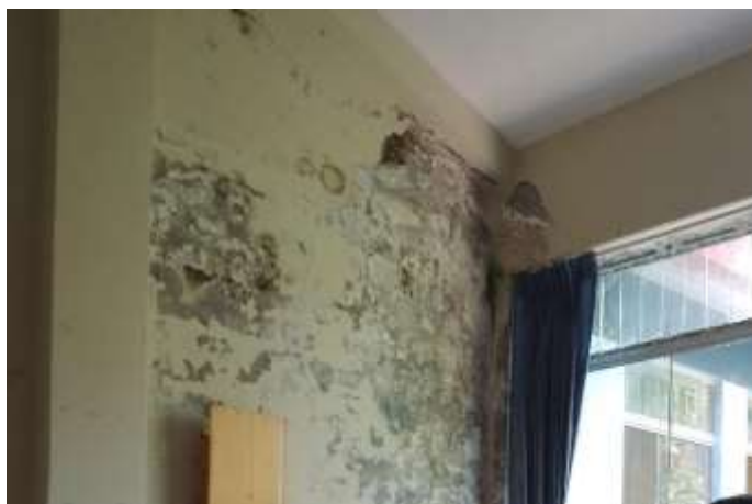
Vista de las manchas, moho y exfoliación de la pintura, causado por la humedad. Se plantea repintado. Ambiente de Nutrición
