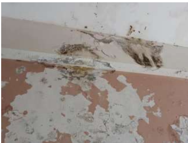
Vista del proceso de exfoliación de la pintura, fisuras y moho, causado por la humedad. Se planeta resane y repintado. Pared del 2do corredor longitel proceso de exfoliación de la pintura, fisuras y machas de moho, causado por la humedad. Se planeta resane y repintado. Pared del 2do corredor longitudinal
