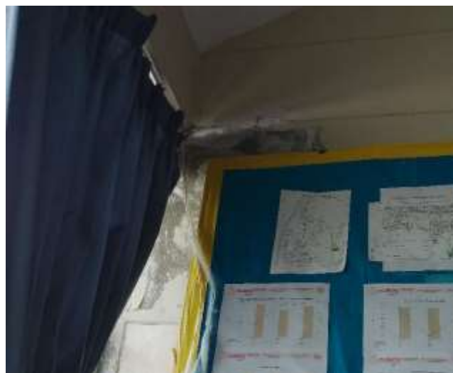
Vista de la exfoliación de la pintura, causado por la humedad. Se plantea repintado. Ambiente de Ecografía
