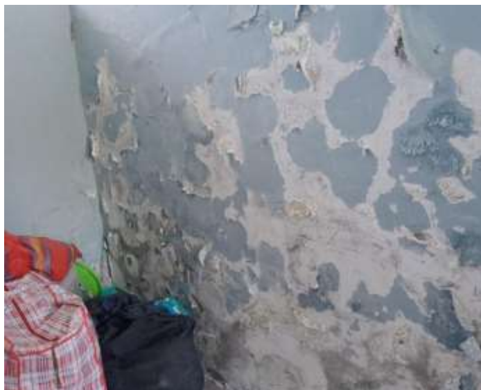
Vista de la exfoliación de la pintura causado por la humedad. Se plantea repintado. Ambiente de almacén central-interior
