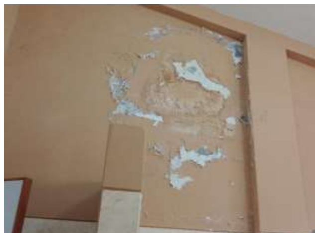
Vista del proceso de exfoliación de las capas de pintura, causado por la humedad. Se plantea el repintado. Pared del 1er corredor transversal
