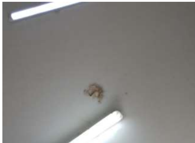
Vista de mancha y exfoliación del cielo raso, causado por la humedad. Se planeta repintado. Ambiente de Odontología
