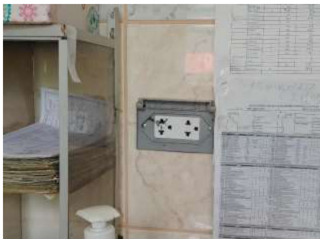
Vista que detalla, toma corriente dañado. Se plantea su cambio. Ambiente laboratorio.
