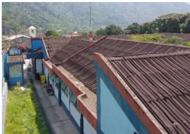
Vista panorámica donde se aprecia la falla generalizada de la cobertura. Bloque de consultorios externos
