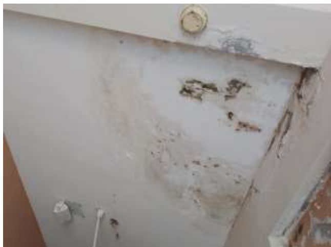
Vista de manchas y exfoliación del cielo raso. Se plantea limpieza y repintado. 2do corredor longitudinal
