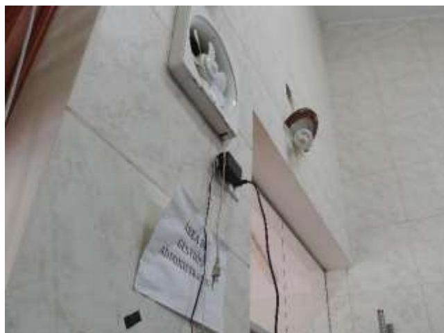
Vista de la instalación eléctrica provisional. Se plantea su reinstalación. Ambiente Farmacia
