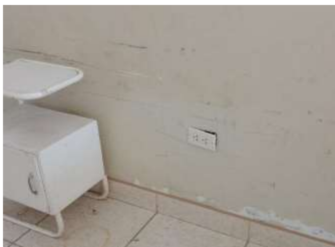
Vista del tomacorriente dañado. Se plantea cambio e instalación fijada a la pared. Ambiente Pediatria
