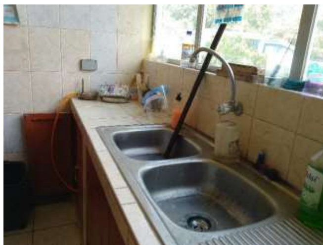
Vista del grifo de caño tipo gancho dañado. Se platea cambio del accesorio. Ambiente de laboratorio
