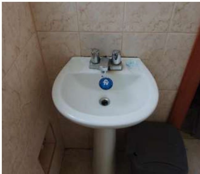
Vista del grifo de lava mano dañado con goteras. Se platea su cambio. Ambiente baño de Pediatría
