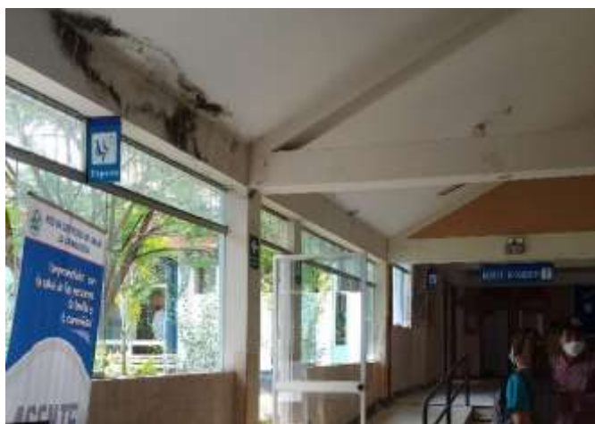
Vista donde se observa manchas en el cielo raso, causadas por la húmeda presencia de moho. Se plantea limpieza y repintado- 1er corredor longitudinal.
