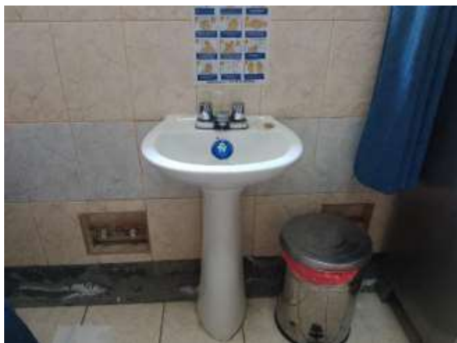
Vista de grifo de lava mano dañado con goteras. Se platea su cambio. Consultorio de medicina
