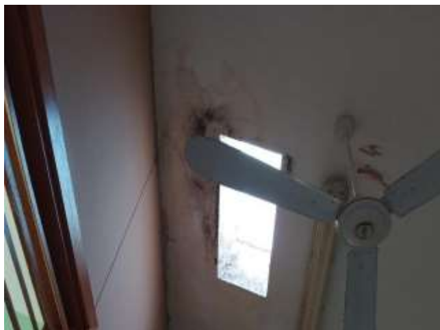
Vista de manchas con moho del cielo raso. Se plantea repintado. 1er corredor longitudinal
