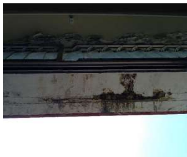
Vista del alero con manchas y exfoliación de la pintura. Se plantea repintado.
