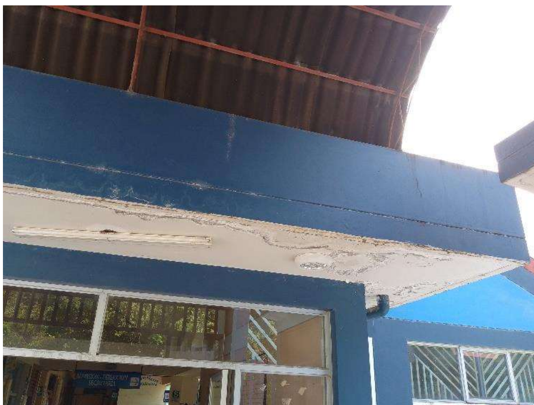
Vista de fisuras y exfoliación de las capas de pintura, alero de la facha principal. Se plantea repintado
