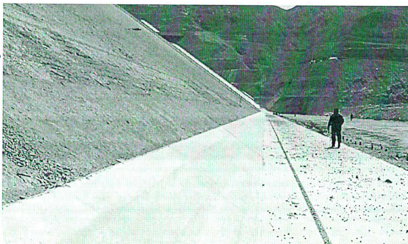
Figura 7. Obsérvese el plinto en el cauce de quebrada
