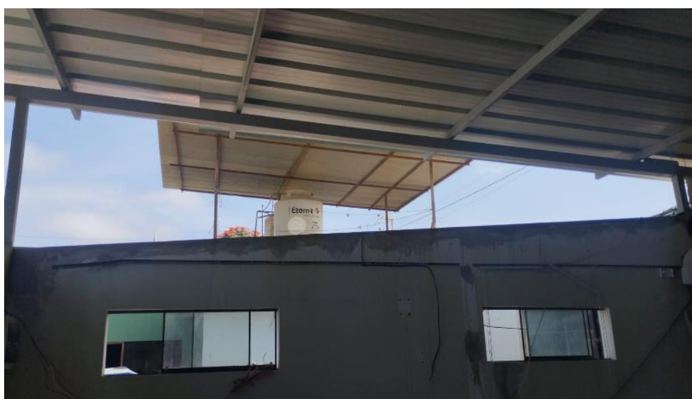
La cobertura del CEM, fue elevada a fin de tener mayor pendiente para la evacuación del agua de lluvias.
