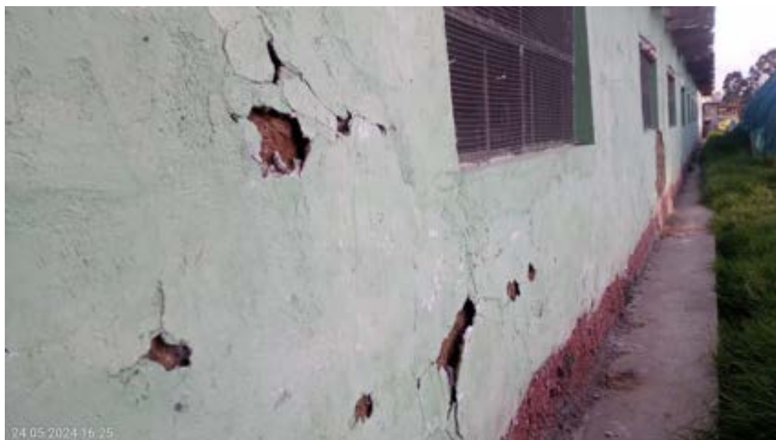
Fotografía n°04: Desgaste de yeso en fachada posterior del galpón n°01.
