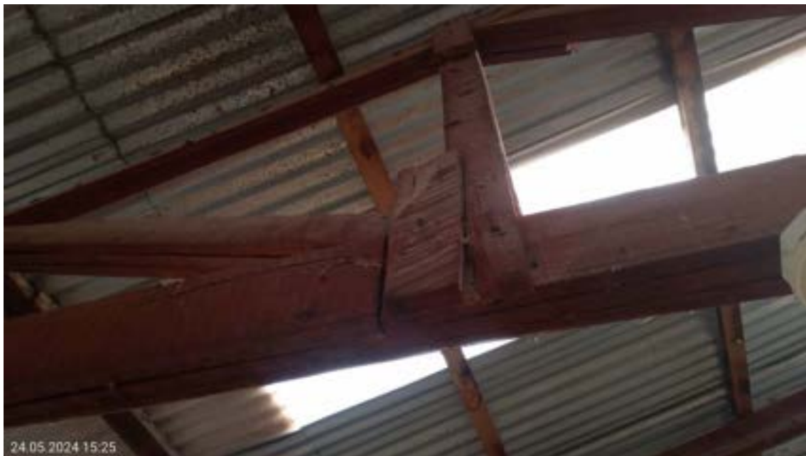
Fotografía n°11: Tijera de madera interior en estado de deterioro, Galpón n°03.
