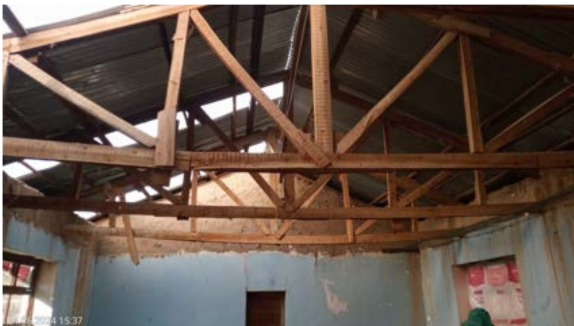
Fotografía n°10: Armadura de madera interior en estado de deterioro, Galpón n°03.
