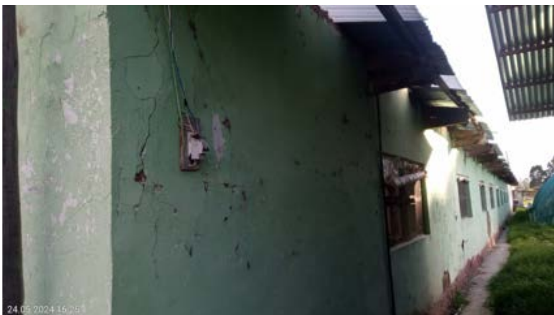
Fotografía n°06: Artefacto eléctrico expuesto a la intemperie, Galpón n°01.
