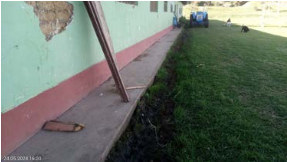
Fotografía n°01: Desgaste de yeso en fachada lateral del galpón n°01.
