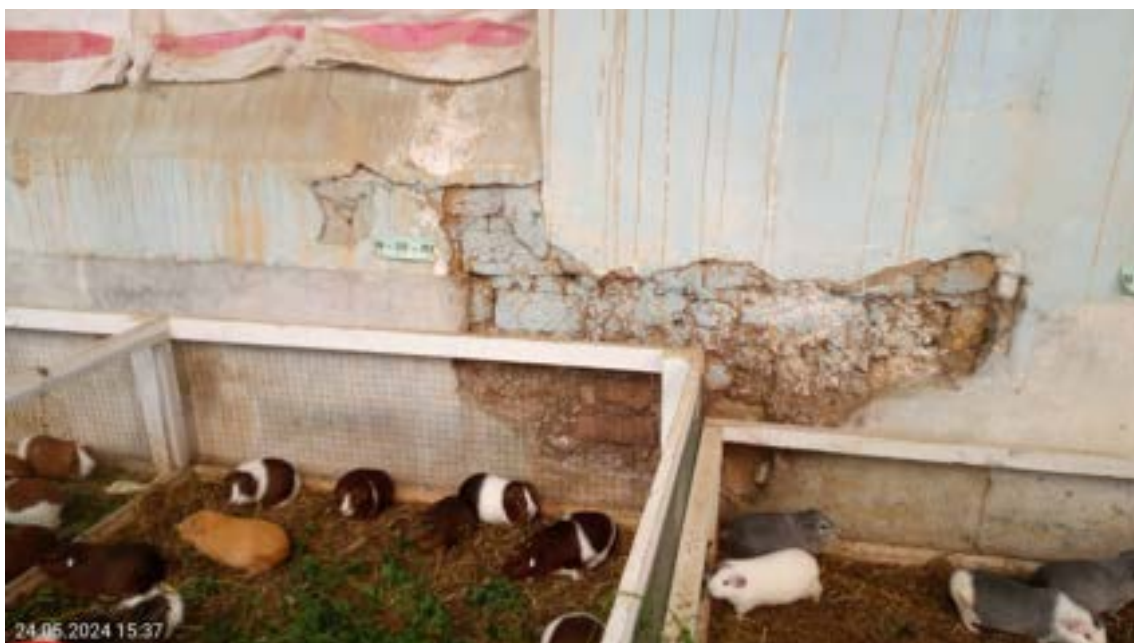
Fotografía n°08: Desgaste de yeso en muro interior del galpón n°02.
