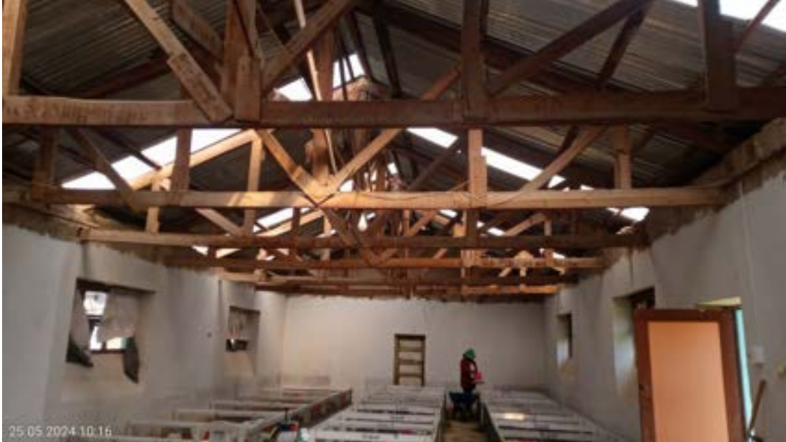
Fotografía n°17: Interiores de galpón n°02 en estado de deterioro.
