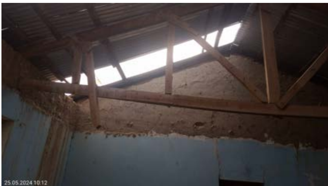
Fotografía n°20: Tijerales en completo estado de deterioro. Galpón n°02.
