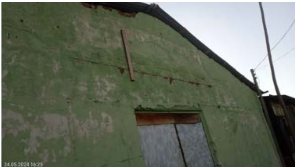
Fotografía n°03: Desgaste de yeso, en fachada principal del galpón n°01.
