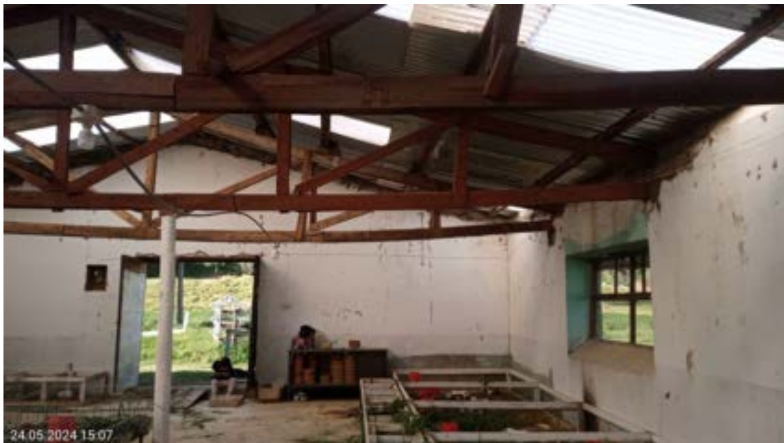
Fotografía n°13: Armadura de madera interior en estado de deflexión, Galpón n°01.
