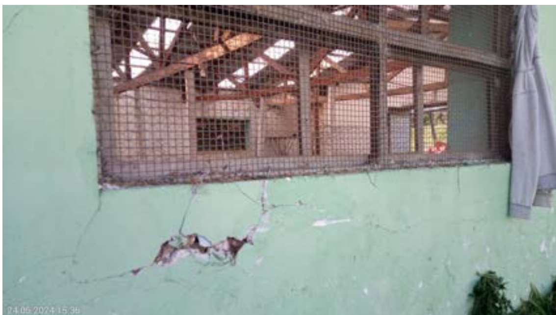
Fotografía n°12: Ventana de madera y malla metálica en estado de deterioro.
