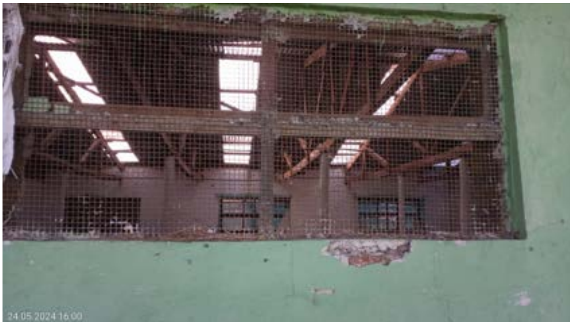
Fotografía n° 07: Ventana de madera y malla metálica en estado de deterioro.
