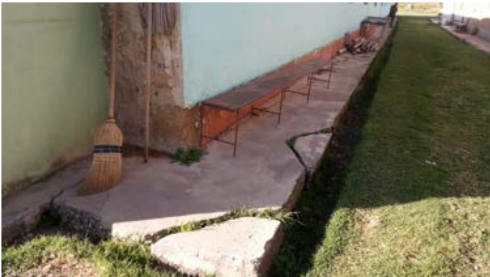
Fotografía n°02: Vereda de concreto en estado de deterioro, Galpón n°03.
