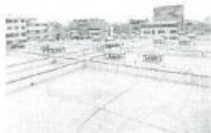
IMAGEN 02: COBERTURA DE ACRILICO DESGASTADAS DEL AMBIENTE DE GINECOLOGIA.
