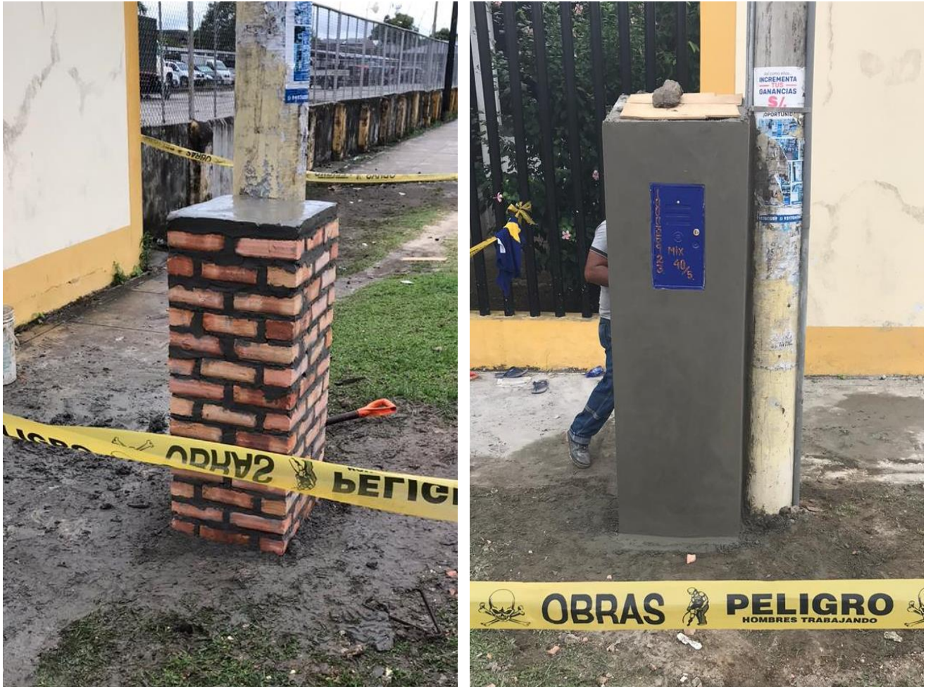
Figura N° 4: Proceso constructivo de un murete para clientes mayores
