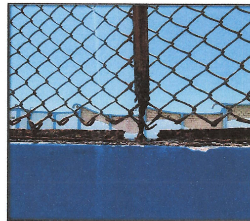
Fotografia N° 01: Se observa la oxidación y desintegración de angulos en malla de seguridad.
