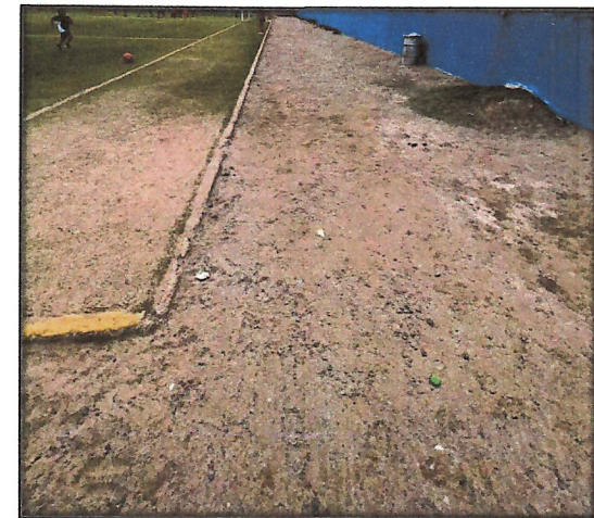
Fotografía N° 06: Observamos el mal estado del sardinel que rodea al campo de grass sintético.
