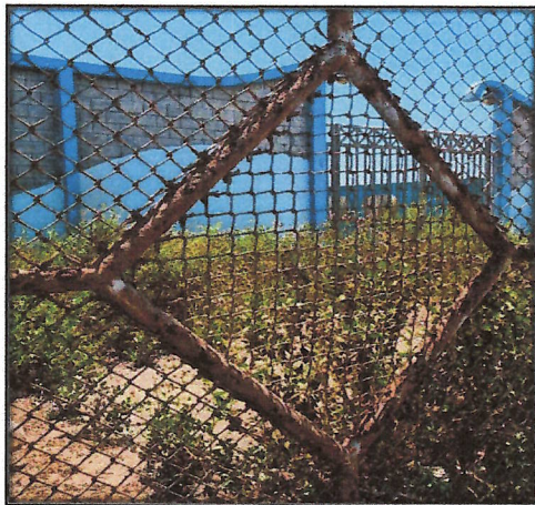
Fotografía N° 04: Observamos la oxidación en marcos de portón de acceso.
