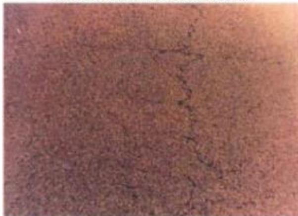
Gravedad 2: fisuras finas en las huellas del tránsito
