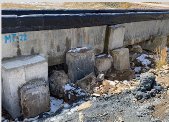
Vista de base erosionado
