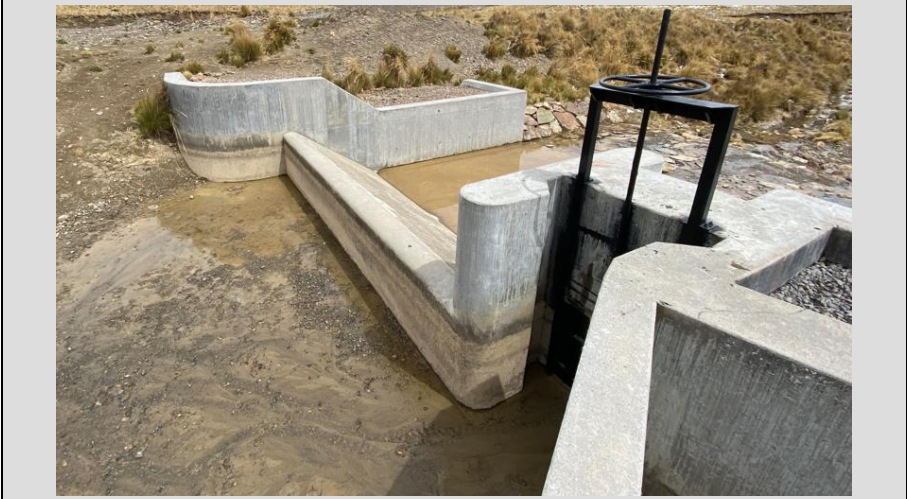
Sistema de barraje fijo con compuerta
