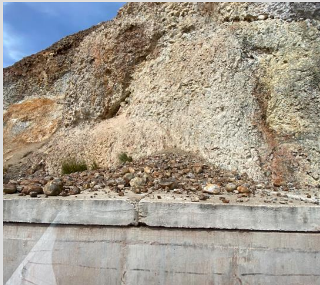
Derrumbe sobre tapas de canales
