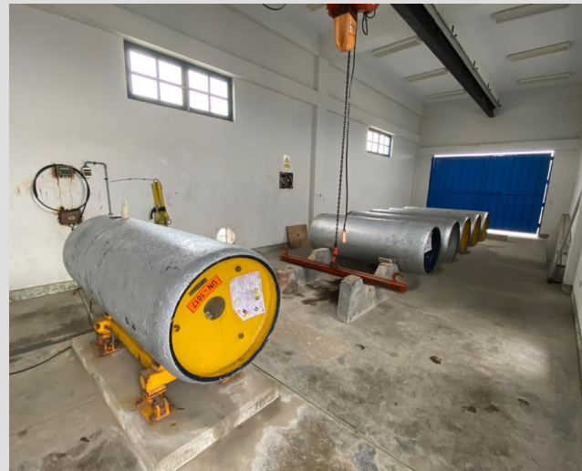
Tanques de gas cloro
