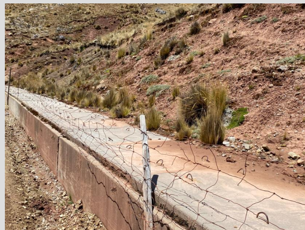
Zona de canales con empuje de deslizamiento
