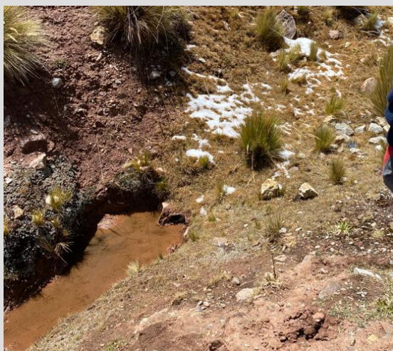
Sistema de drenes horizontales para reducir el nivel freático
