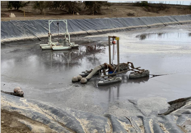
Succión para el sistema de bombeo
