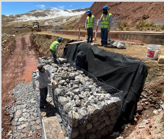
Trabajos de estabilización de la plataforma
