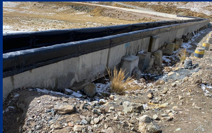
Vista de canal erosionado y con geomalla
