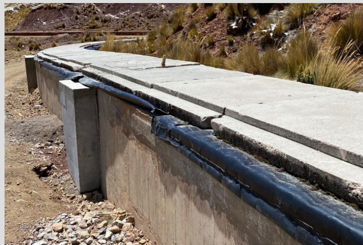
Zona de canales con afectación por deslizamiento y colocación de geomalla.
