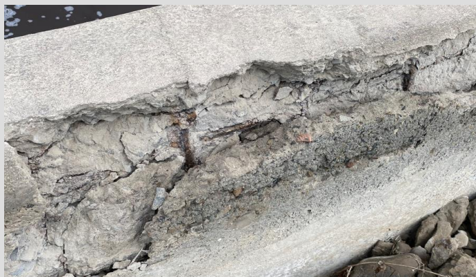
Presencia de oxidación del acero, en muro de poza de cloración
