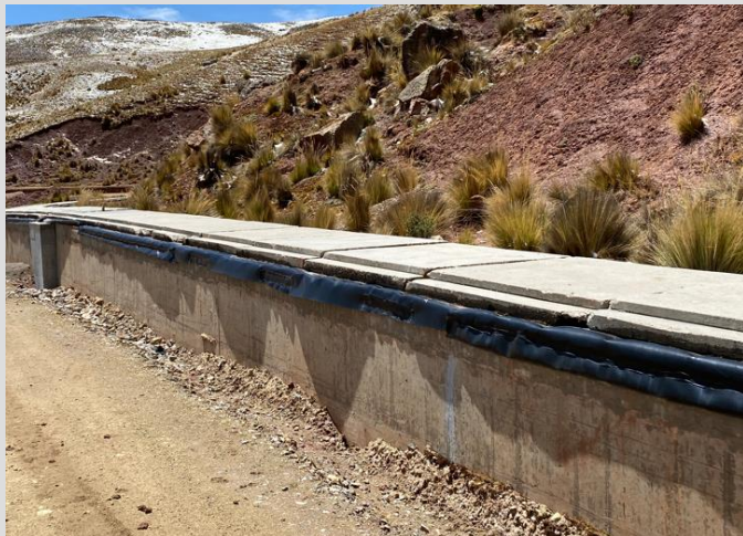
Zona de canales con afectación por deslizamiento y colocación de geomalla.
