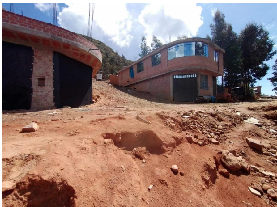
IMAGEN 1: Se puede observar que la entrada de la calle Las Congonas se encuentra en malas condiciones y necesitan una adecuada pavimentación con veredas y cunetas.
