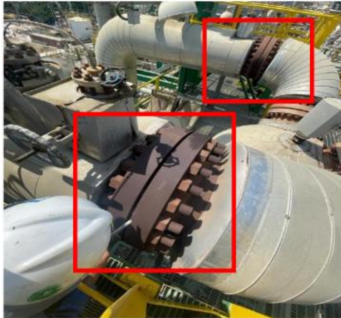
FOTO 01, PARTE SUPERIOR DE RCA-E-001: Fuga en dos (02) uniones bridadas de 24" Ø x 600 psi.
