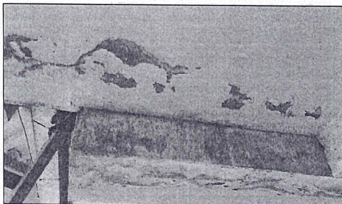
Humedad encontrada en las losas aligeradas por filtraciones en el techo
