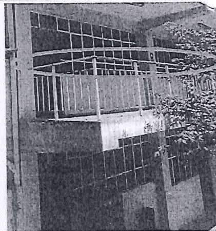
Cambio de pasamanos por existente por uno de fierro galvanizado.
