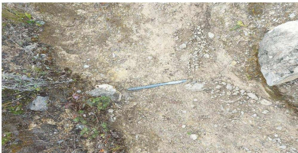
En la presente toma podemos apreciar el mal estado vemos la presencia de tuberías rotas y al aire libre con presencia de fugas de agua.
