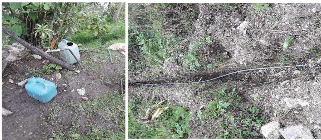
Red de Distribución y Conexiones Domiciliarias en la localidad de Las Palmeras se muestra en malas condiciones (expuestas a rotura y deterioro)
