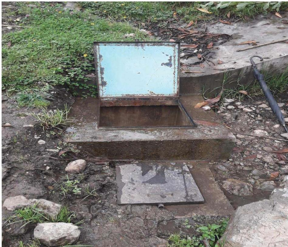
En la presente toma podemos apreciar el mal estado y no cuenta con cerco perimétrico de la estructura de captación existente.
