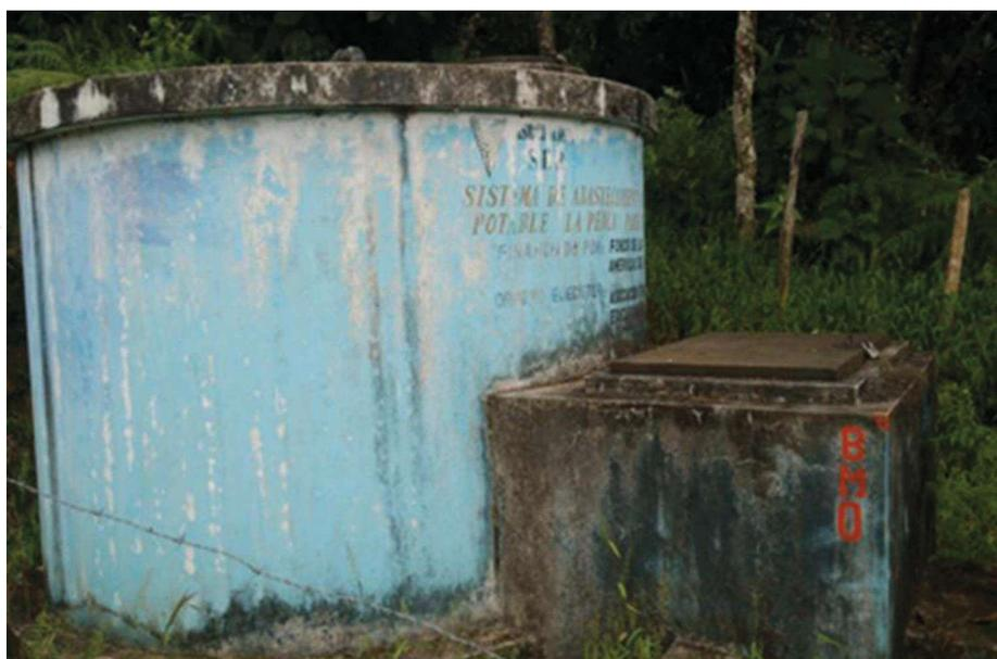
Reservorio existente en la localidad de El Verde Zona Alta se muestra en malas condiciones lleno de vegetación y sin cerco perimétrico.
