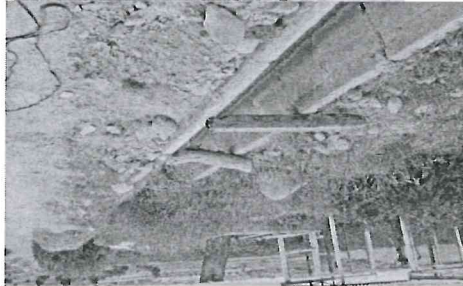
Foto 03: trabajos de encimamiento para evitar pérdidas de agua
