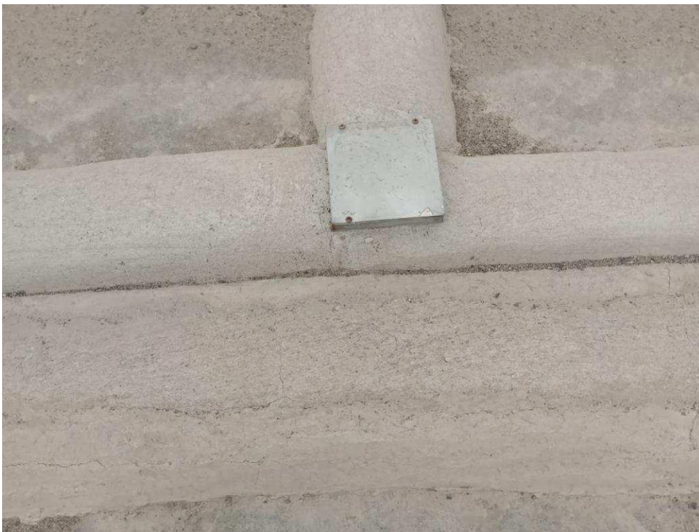
Ilustración 2 - Área de ductos eléctricos y de redes coberturados
