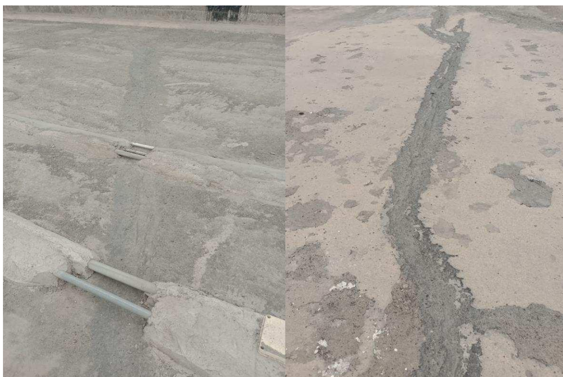
Ilustración 4 - Líneas reparadas con cemento y brea
