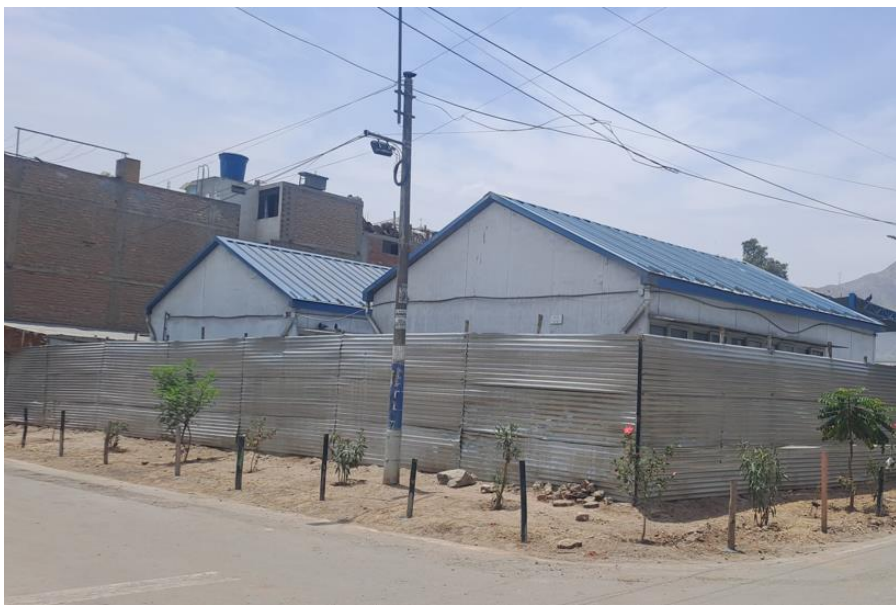
Imagen N° 12: Cerco Perimétrico Vista Posterior: Cerco en Calle Honduras zona posterior a la institución educativa, cerco conformado por paneles de calamina metálica anclados a postes de madera rodilla.
