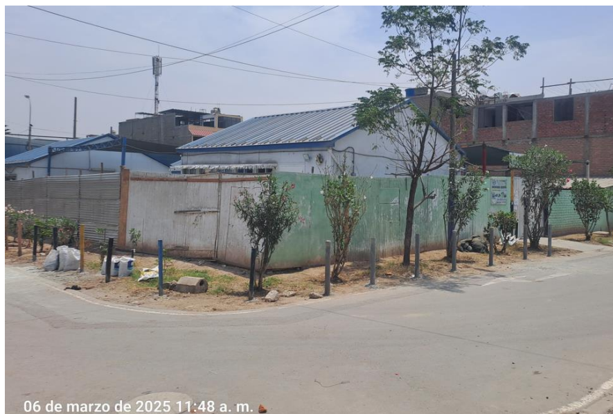
Imagen N° 10: Cerco Perimétrico Vista Lateral: Cerco en Jiron Haití esquina con Calle Colombia, se presenta un cerco conformado por paneles de madera con inclinación hacia el interior de la Institución Educativa.
