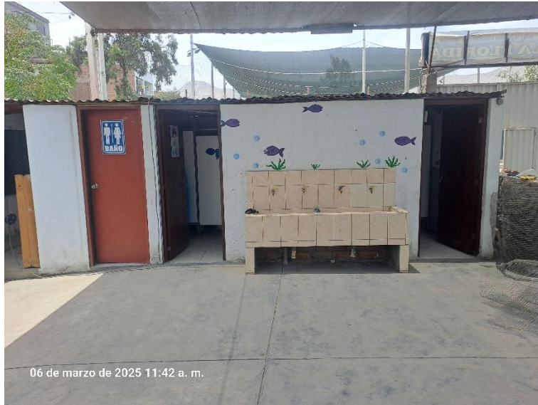
Imagen N° 20: Vista interior del módulo de SS.HH existente: Conformado por muros de albañilería sin elementos de confinamiento y con cobertura plástica.
