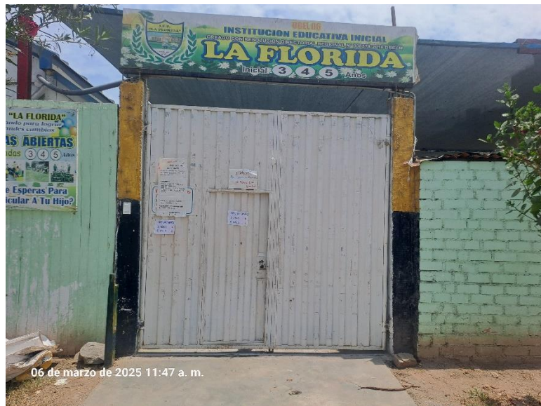
Imagen N° 7: Cerco Perimétrico Vista Exterior Frontal: Portada de ingreso a la Institución Educativa conformada por dos columnas de concreto armada y un portón metálico.
