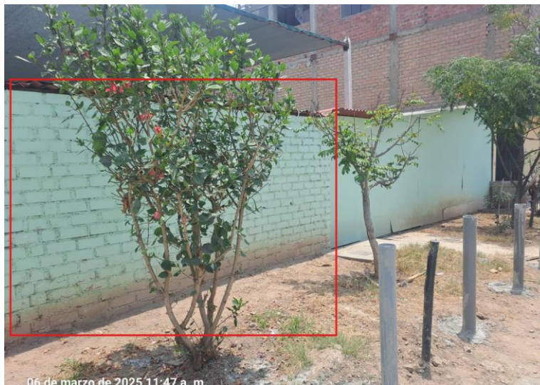
Imagen N° 21: Vista exterior de muros del módulo de SS.HH existente: Muro de albañilería sin presencia de elementos de confinamiento
