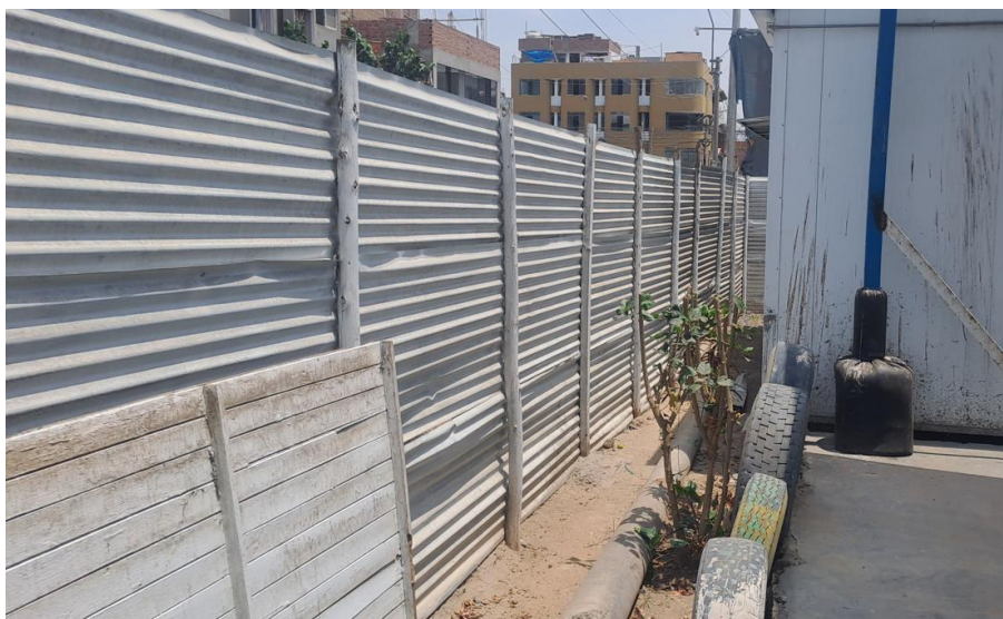
Imagen N° 13: Cerco Perimétrico Vista Interior: Cerco en Jiron Haití, evidencia de postes rollizos sin presencia de un pedestal o cimentación.
