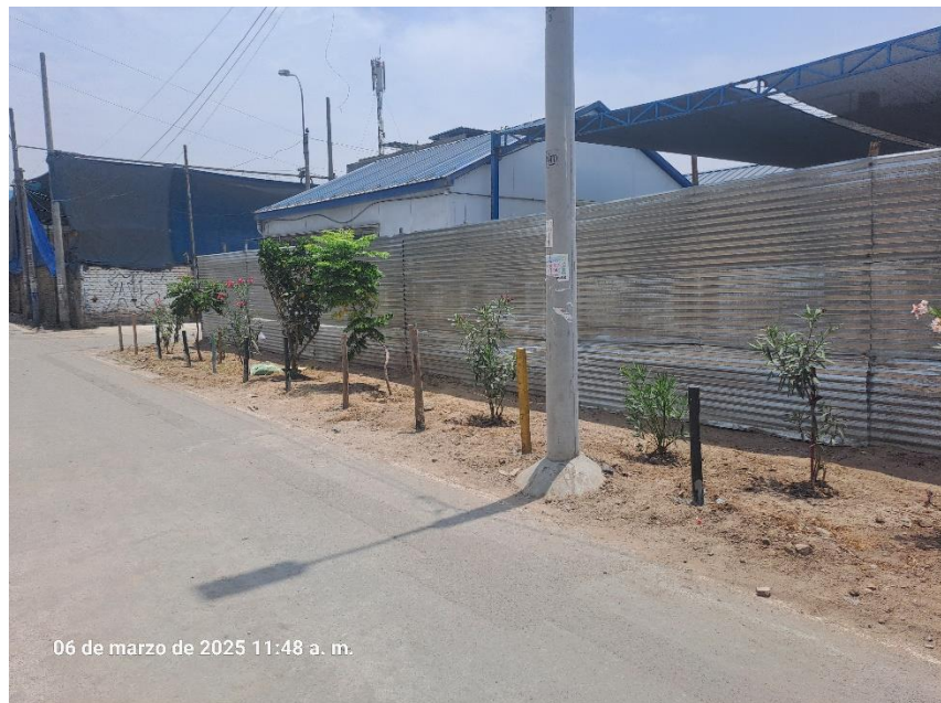
Imagen N° 11: Cerco Perimétrico Vista Lateral: Cerco en Jiron Haiti, se presenta un cerco conformado calaminas metálicas ancladas a postes de madera rolliza.
