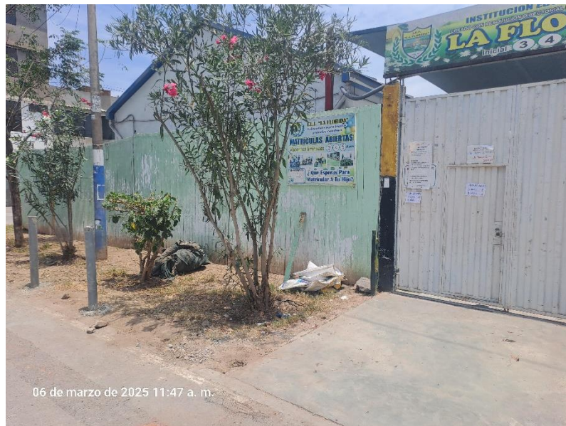
Imagen N° 9: Cerco Perimétrico Vista Exterior Frontal: Vista izquierda del ingreso a la Institución Educativa, evidencia de cerco conformado por paneles de madera.
