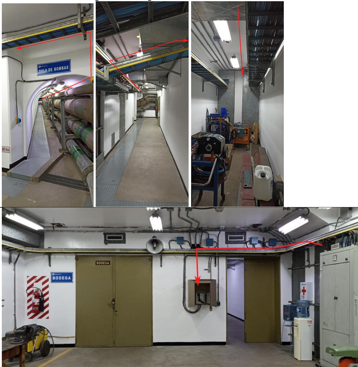
Cableado a teléfono bodega RON desde gabinete sala de bombas
