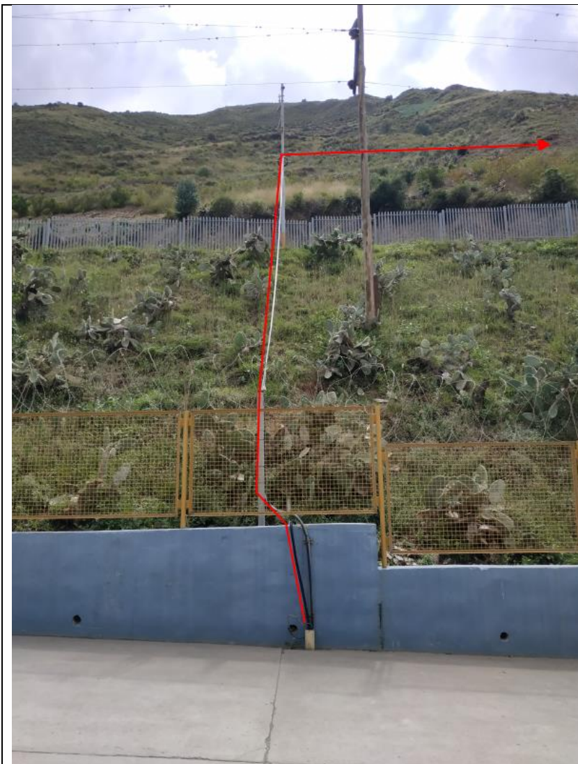
Llegada de la fibra optica al poste costado estación robótica
