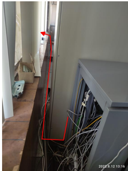
Ruta cableado hacia techo SECA
