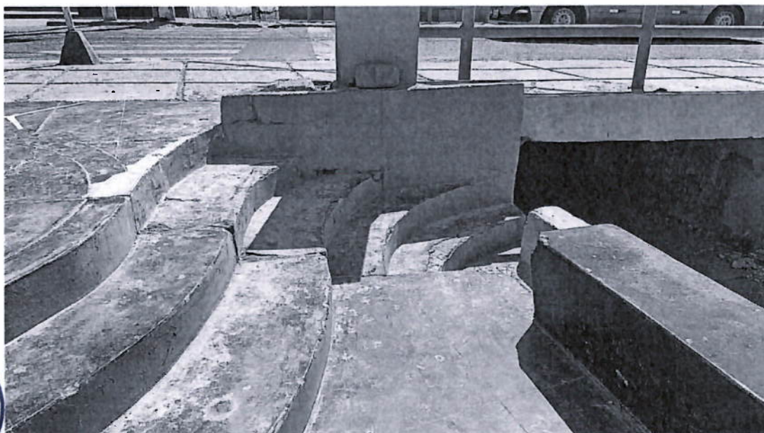
Imagen N°03: Gradas agrietadas Zona Zanjón.
