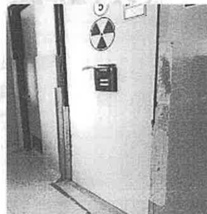
IMAGEN 10: DETERIORO DE LA PARED POR PRESENCIA DE RATAS.
