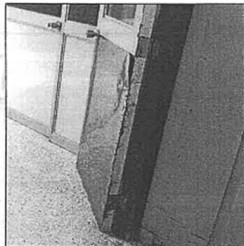
IMAGEN 02: MARCO Y PUERTA DETERIORADO POR FALTA DE MANTENIMIENTO.
