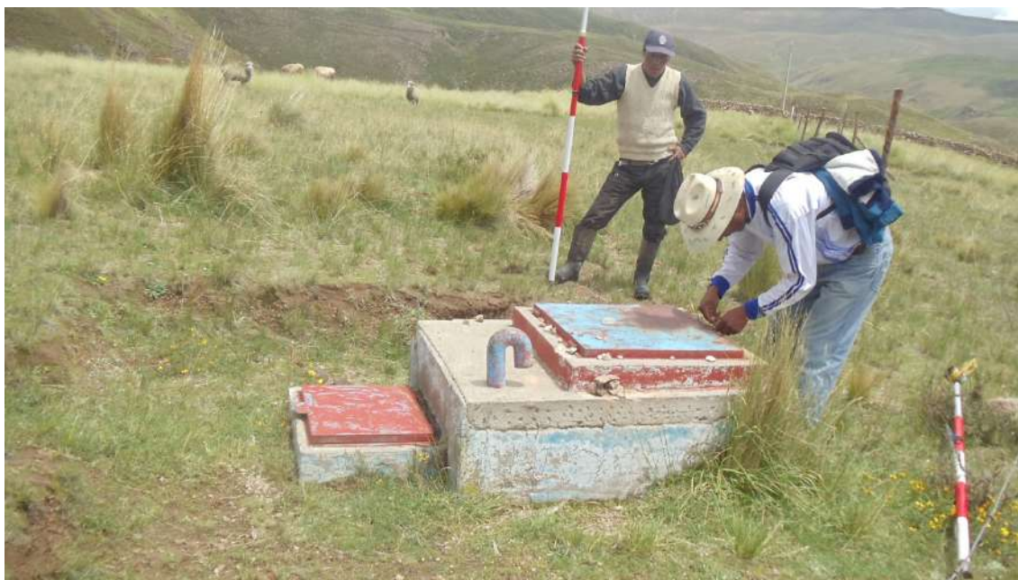
CAMARA ROMPE PRESION SECTOR CCOCHA (EXISTENTE)
