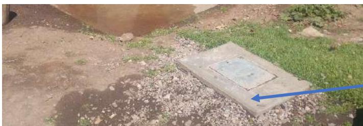
Ilustración 49 Caja de registro de desagüe
