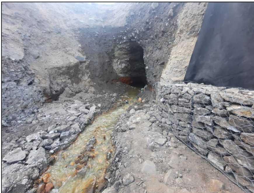
Figura 4: Bocamina ID 8766 (Sección actual 1.5 m x 2.2 m aproximadamente)
