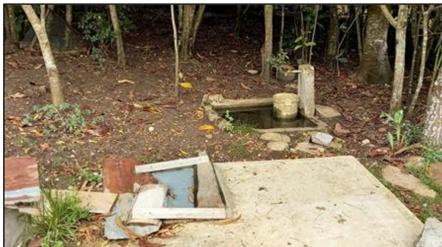
Imagen 10. Conexiones domiciliarias en mal estado.
