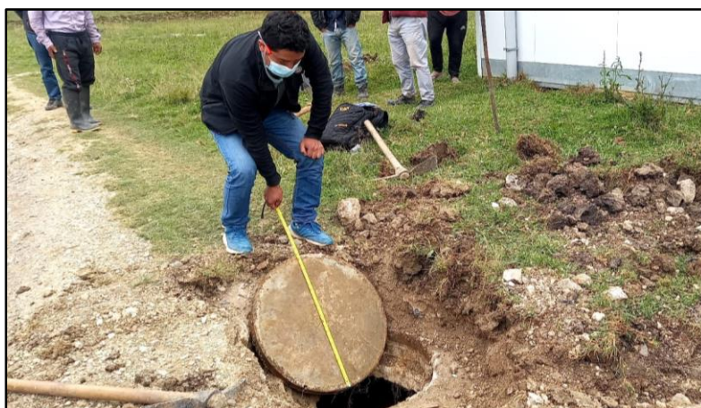
Imagen 20. Buzón existente de alcantarillado en regular estado. Fuente: Elaboración propia.
