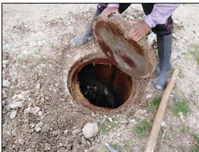
Imagen 16. Buzón existente de alcantarillado en regular estado. Fuente: Elaboración propia.
