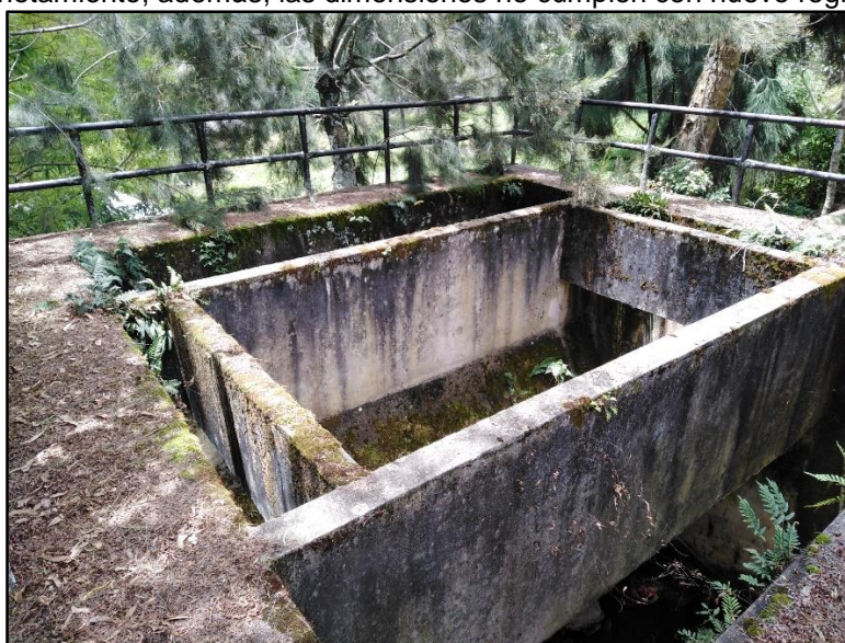
Imagen 25. Tanque Imhoff en mal estado.
