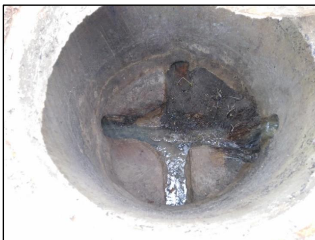
Imagen 17. Buzón existente de alcantarillado en regular estado. Fuente: Elaboración propia.
