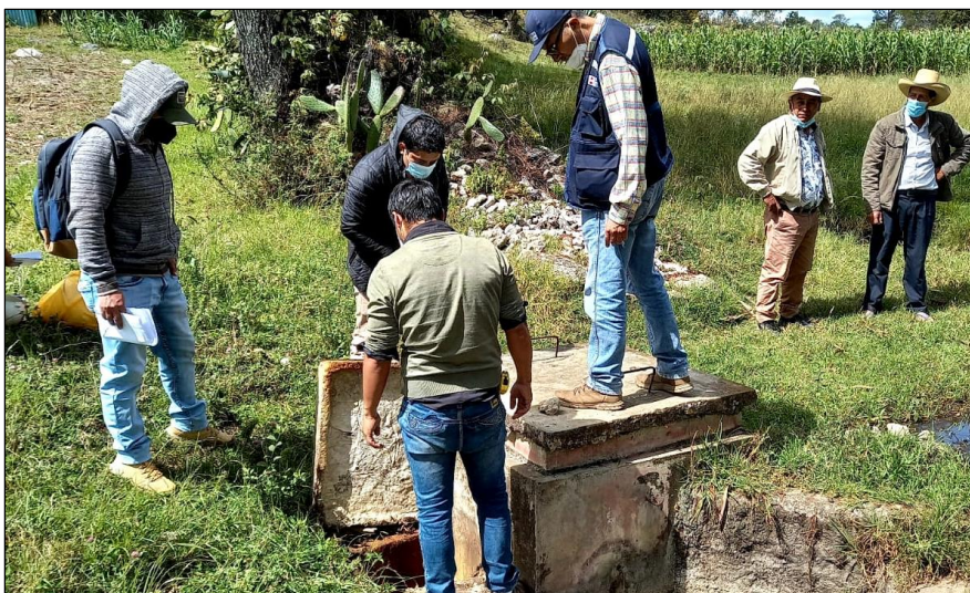
Imagen 4. Captación de ladera “Apangoray”, en mal estado.
