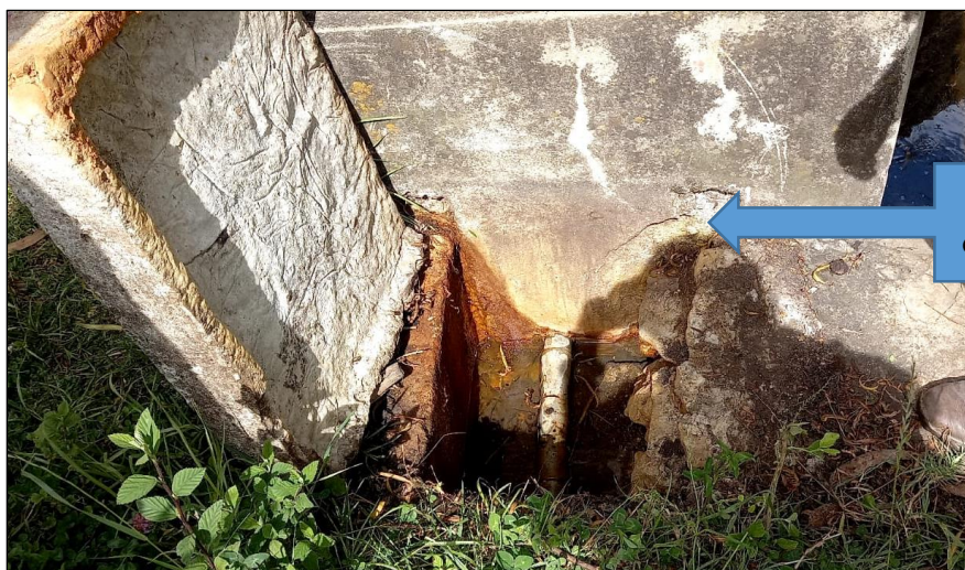
Imagen 5. Caja de válvulas de la captación "Apangoray" en mal estado.
