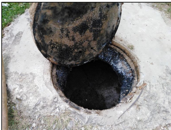
Imagen 15. Buzón existente de alcantarillado colmatado de sedimentos. Fuente: Elaboración propia.
