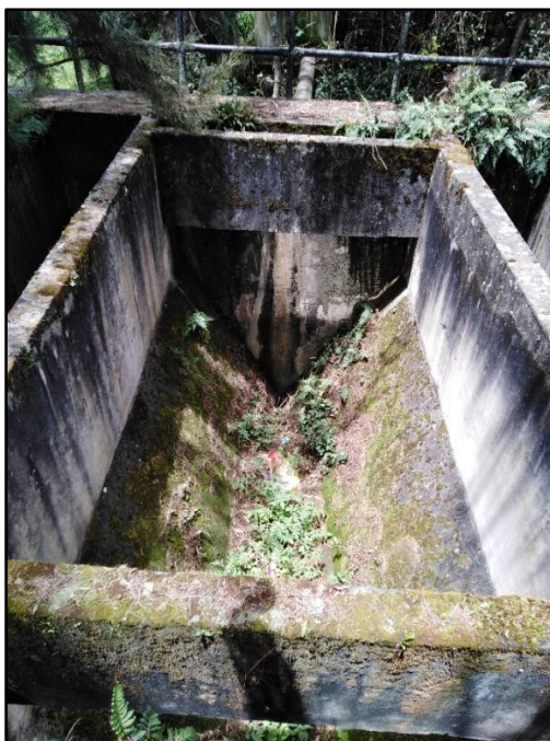
Imagen 26. Tanque Imhoff actualmente inoperativo.
