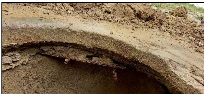
Imagen 22. Buzón existente de alcantarillado, sin recubrimiento de acero. Fuente: Elaboración propia.
