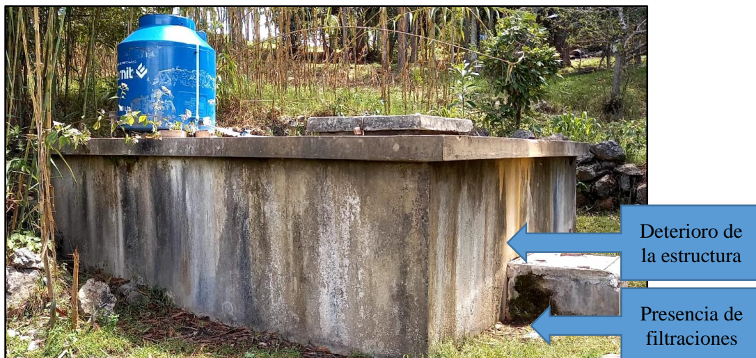
Imagen 8. Reservorio existente rectangular de 24 m 3 , en regulares condiciones.
