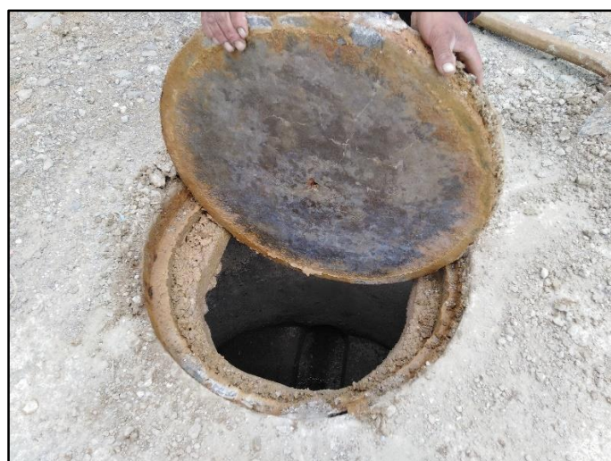
Imagen 14. Buzón existente de alcantarillado en regular estado. Fuente: Elaboración propia.
