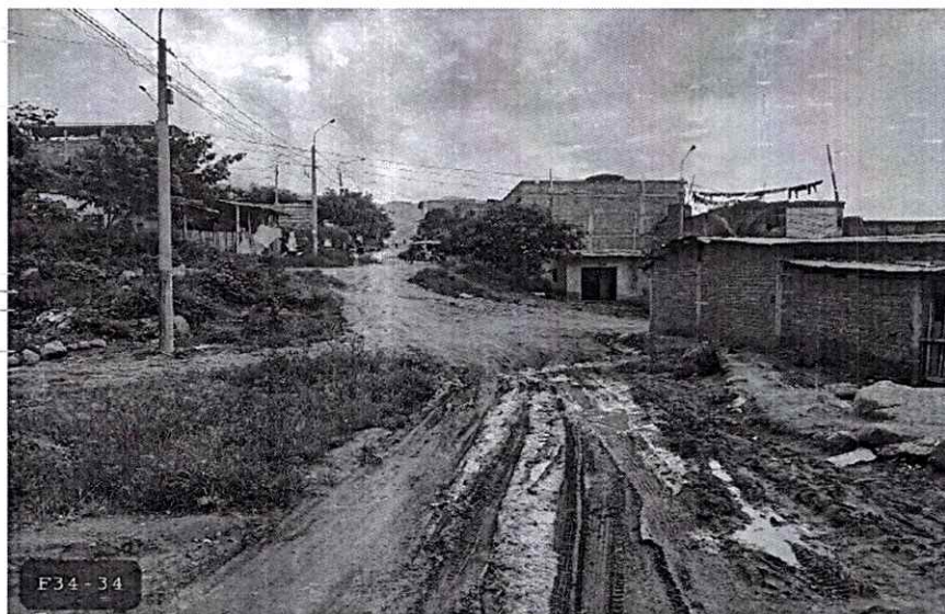
Fotografía N° 5 Vista Calle F. Orellana Cuadra N° 13. Se aprecia escorrentía y encharcamiento de aguas superficiales, puesto que no existe un sistema de drenaje pluvial.
