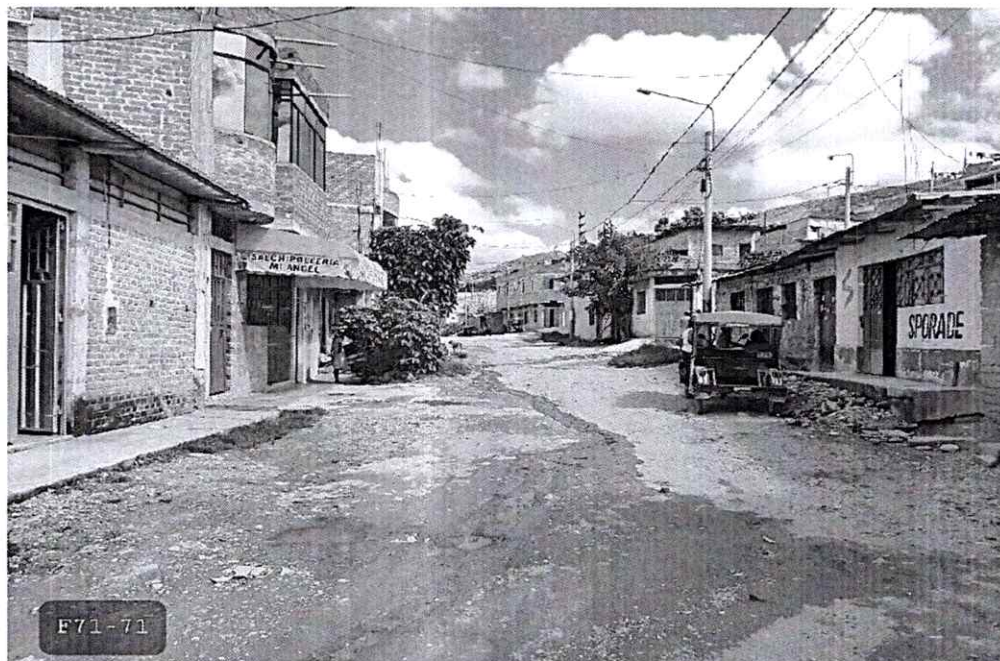
Fotografía N° 6 Vista Calle San Carlos N° 07. Se aprecia escurrimiento de agua, producto de carencia de drenaje pluvial. Presencia de postes de alumbrado eléctrico.
