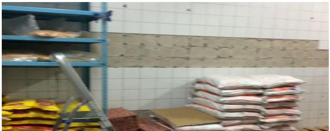
DESPRENDIMIENTO DE MAYOLICA EN LAS PAREDES
