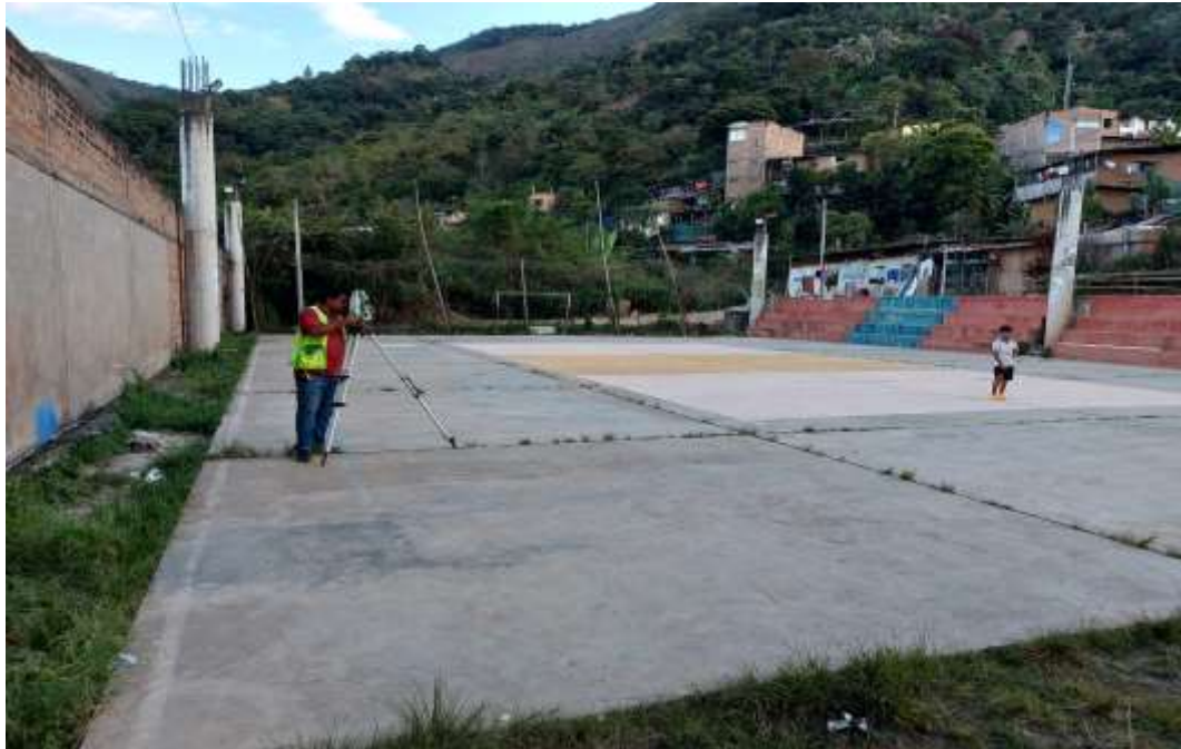
FOTO 02: vista panorámica de la losa multideportiva del sector bajo de la localidad La Coipa Se evidencia las columnas de concreto, sobre las cuales se montará la cobertura metálica
