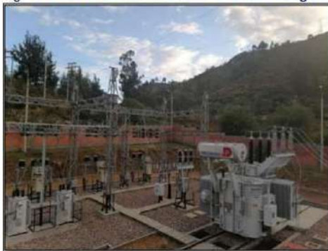
Fig. 19. Patio de llaves en 22.9 kV de la SET Cangallo.
