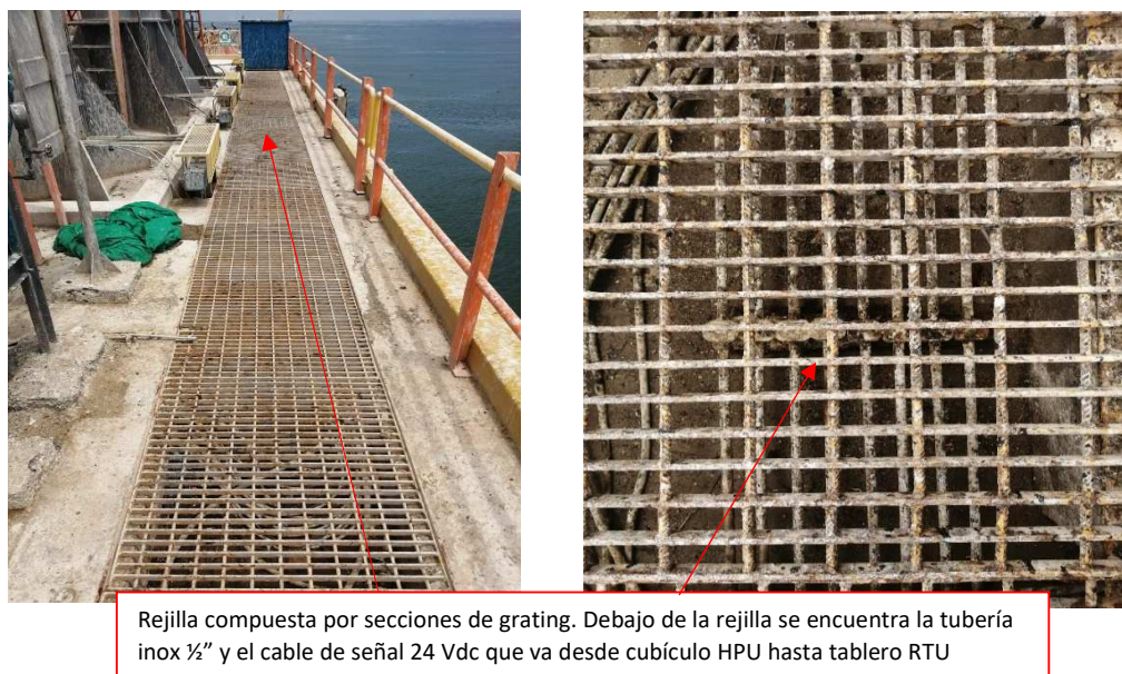
Figura 8. Rejilla de protección de tubing hidráulico
