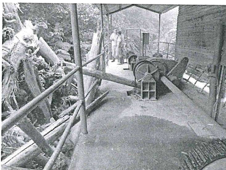
Vista de palizada y un tronco atraviesa parte del sistema del servomotor tensionando los cables (cable de 34"). Requiere limpieza cuidadosa.
