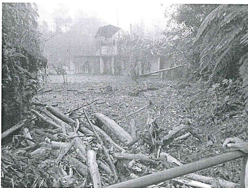
Vista del canal de ingreso del desarenador. Se aprecia la altura del dique de troncos que conforma la palizada, esta llegó por sobre la cota de los muros laterales.
