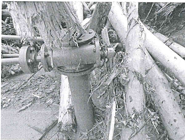
Se puede apreciar como los troncos llegaron a cubrir los Carretes Radiales (En la zona de la Captación).
