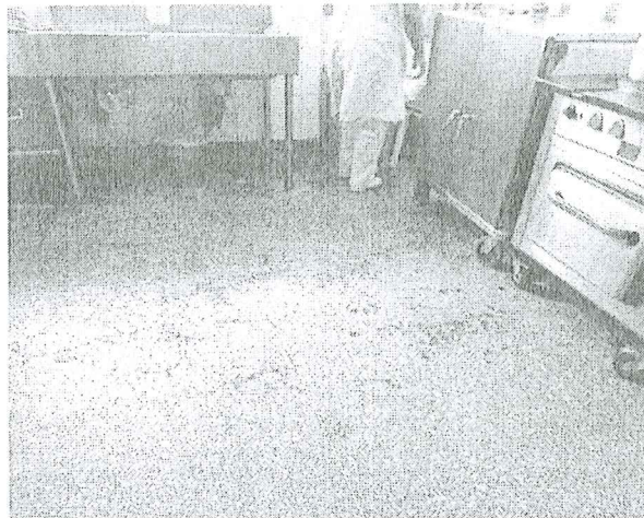
IMAGEN 01: Se muestra el piso de terrazo presenta deterioro, agujeros, terrazo desprendido.
