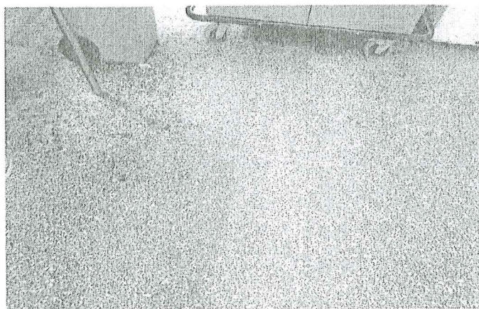
IMAGEN 04: Se muestra el piso de terrazo presenta deterioro, agujeros, terrazo desprendido.
