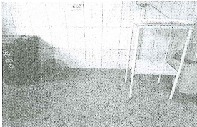
IMAGEN 03: Piso de terrazo deteriorado y cerámicos rotos en zócalo.
