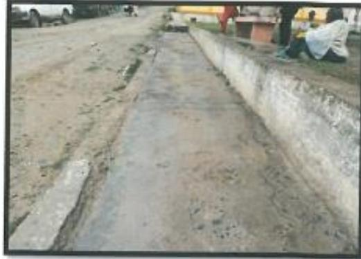
Foto N°02: Se aprecia las veredas de concreto que forma parte de los componentes de la plaza de armas en intervención. A la fecha se evidencia el desgaste de su superficie por efectos del intemperismo y por la falta de mantenimiento del mismo que los beneficiarios no han realizado; motivo por el cual se está considerando su reemplazo dentro de las metas físicas.
