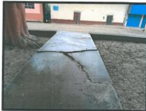
Foto N°03: Se aprecia el estado de deterioro severo de cierto sector de las veredas de concreto que forman parte de los componentes de la plaza de armas en intervención; motivo por el cual se requiere su reemplazo de forma inmediata.
