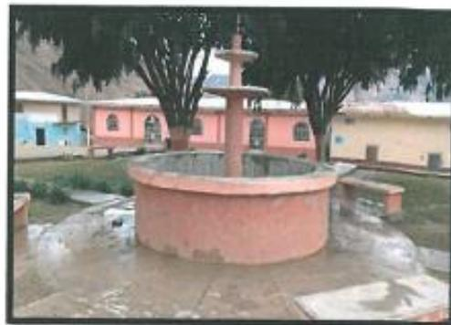
Foto N°06: Se aprecia el deterioro y falta de mantenimiento de las áreas verdes de la Plaza de Armas del Centro Poblado de Pomacucho por parte de los beneficiarios, así mismo se evidencia la falta de sardineles de concreto con el fin de evitar el ingreso de animales.
