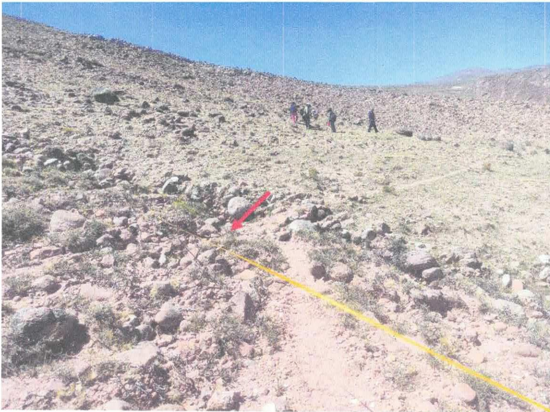
Foto N° 04.- Deslizamiento de taludes superior e inferior que disminuye el ancho de la plataforma.
