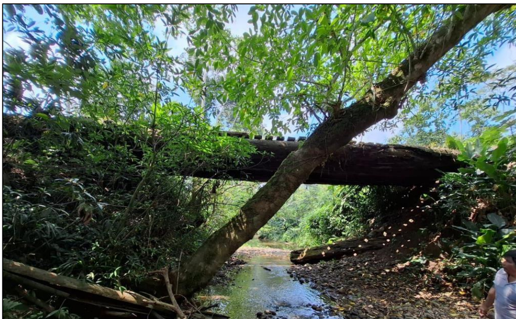
Figura N°8. Vista de cauce y fondo de viga de puente de madera en malas condiciones
