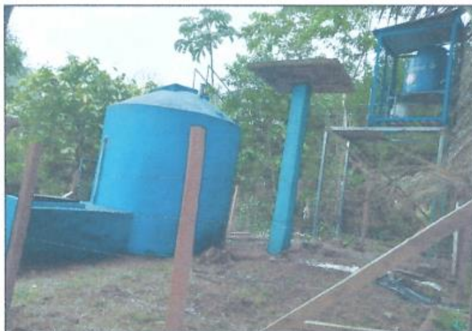
IMAGEN N° 10. RESERVORIO CIRCULAR EXISTENTE DE 10 M3
