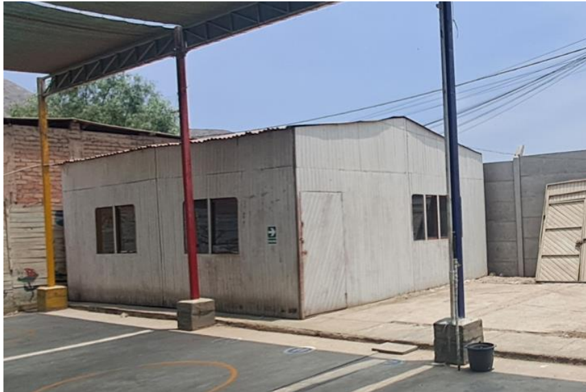
Imagen N° 8: Módulo de aulas prefabricado existente: Estructura de paneles de madera y cobertura de calamina plástica.
