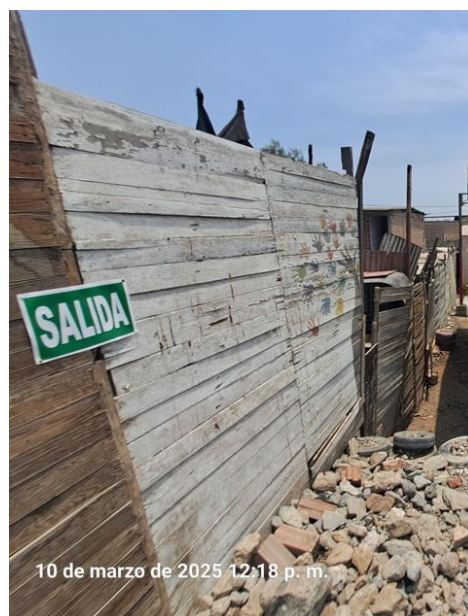
Imagen N° 20: Vista interior del lindero izquierdo: Desnivel en el cerco del lindero izquierdo, falta de cimentación o anclaje que garantice la estabilidad del cerco perimétrico.
