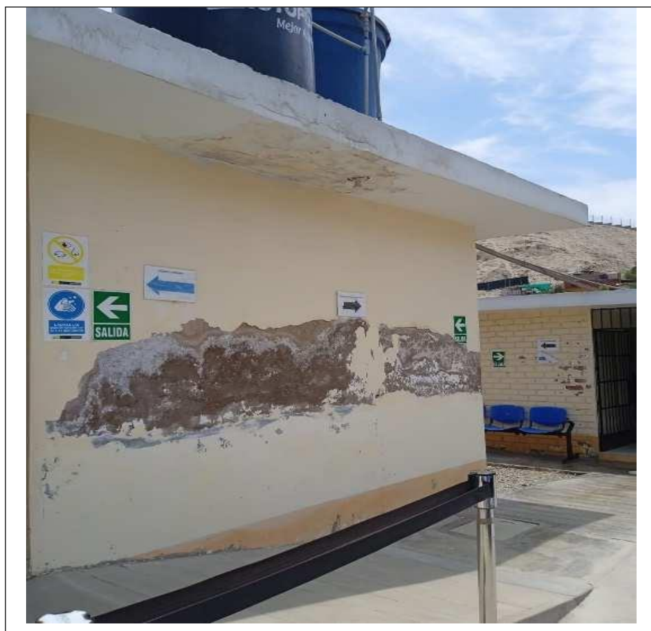
Fotografía 3. Se observa las paredes de ambientes baños se encuentran humedecidas en mal estado de conservación
