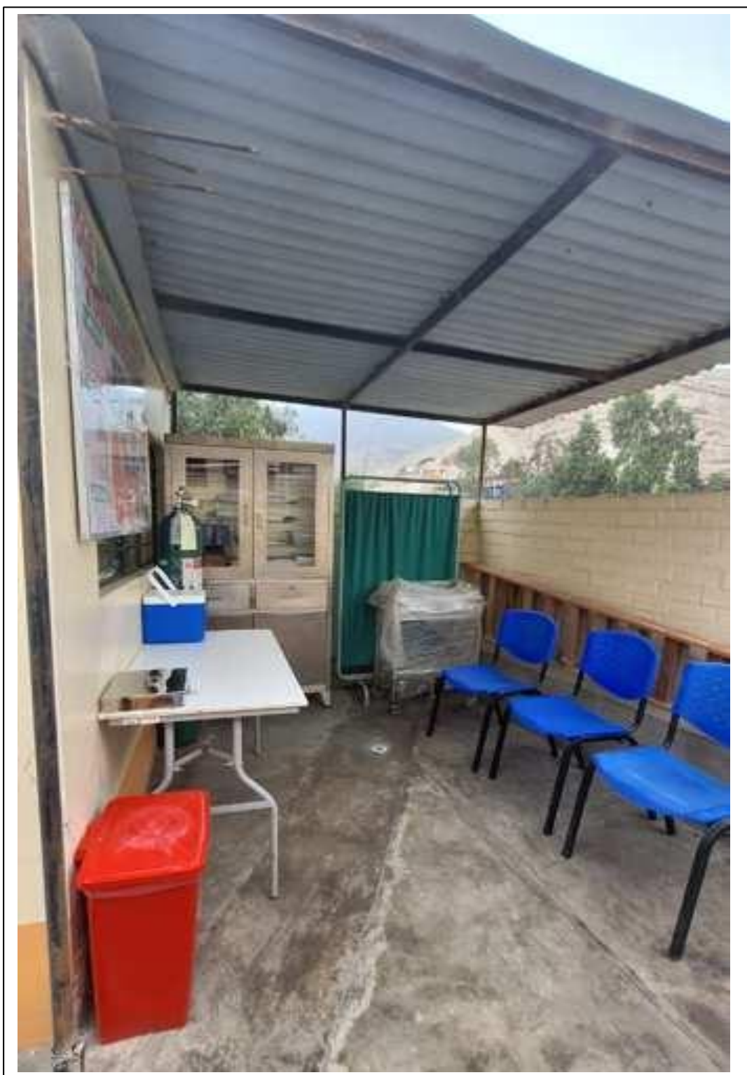
Fotografía 11. Se observa el ambiente de PCT con paredes incompletas, piso pulido en mal estado, además de una cobertura de techo oxidada.
