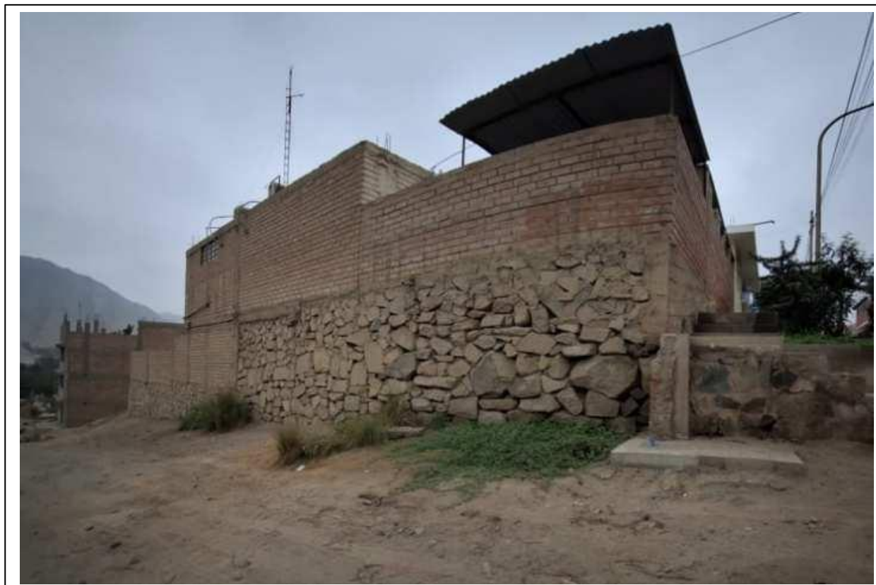
Fotografía 12. El Centro de Salud se encuentra sobre un muro de mampostería de piedra hecho de manera rudimentaria
