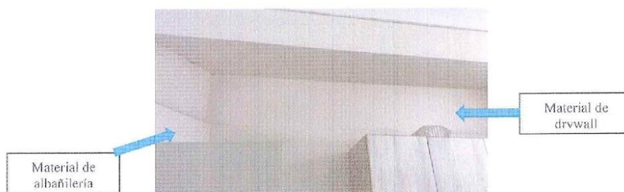
Figura 2.: vista primer nivel de muro no portante, a una altura desde el piso terminado de 2.2m y el resto hasta el fondo de viga de altura de material drywall
