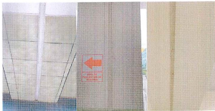
Figura 1: grieta a lo largo de la columna, viga y losa en la unión de dos bloques estructurales.
