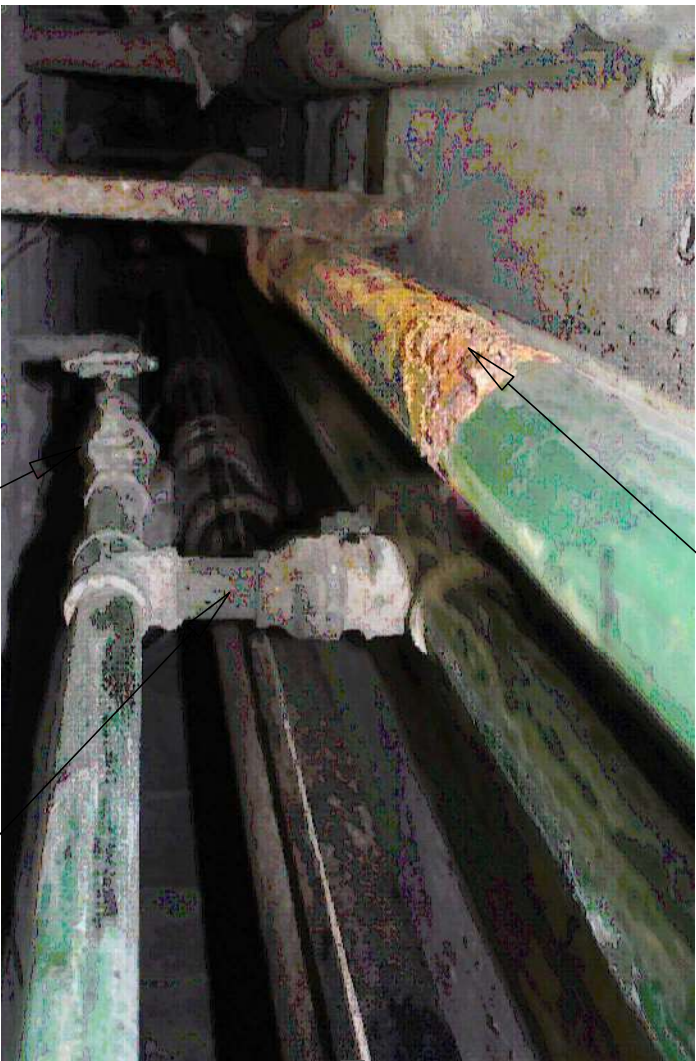
TRAMO EN FIERRO GALVANIZADO, CON PRESENCIA DE CORROSION
