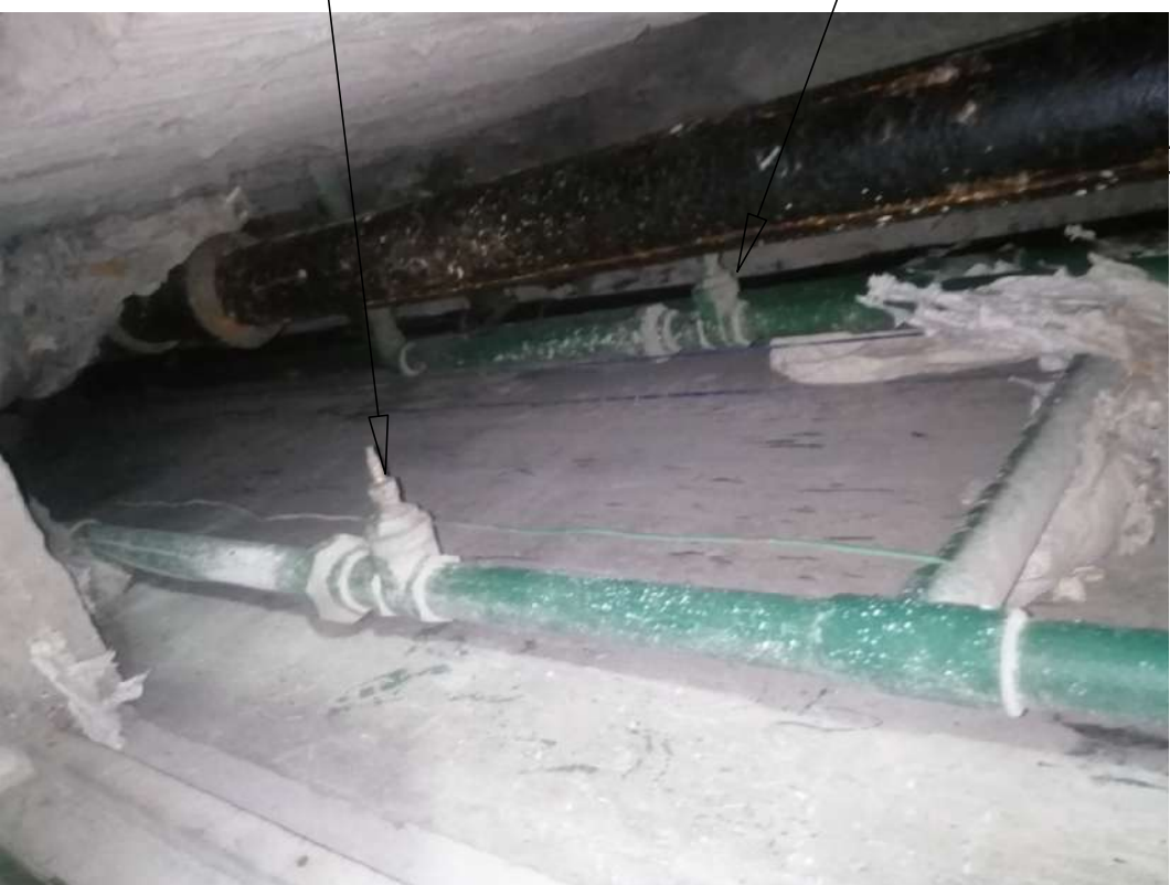
VALVULA DE CONTROL EN MAL ESTADO
