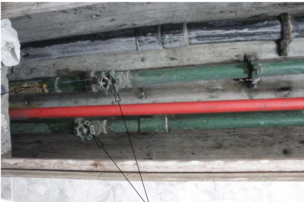
VALVULA DE CONTROL EN MAL ESTADO
