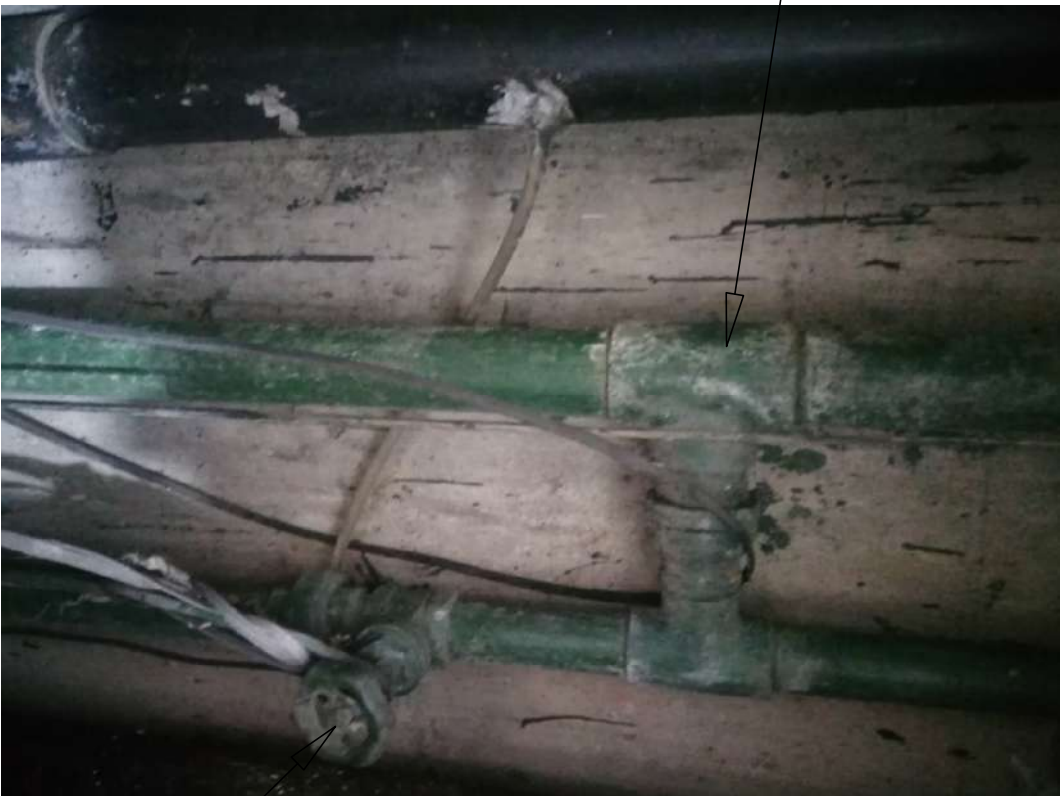
VALVULA DE CONTROL EN MAL ESTADO
