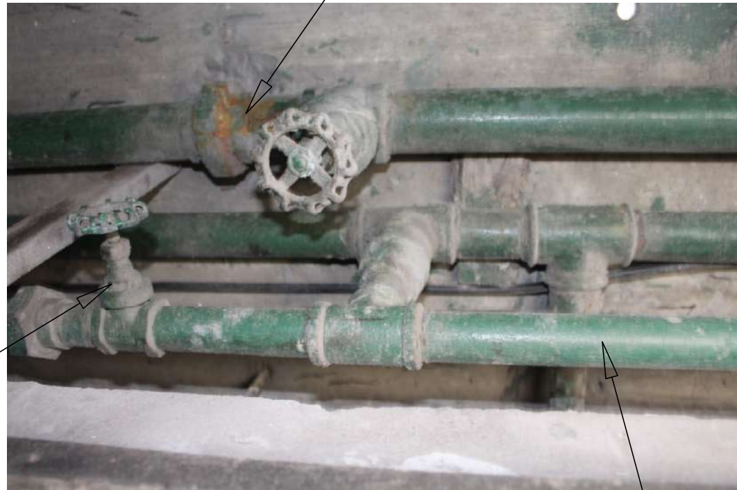
VALVULA DE CONTROL EN MAL ESTADO
