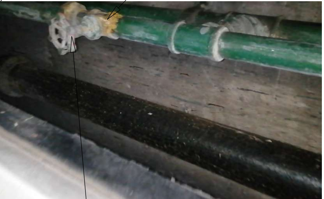
VALVULA DE CONTROL EN MAL ESTADO
