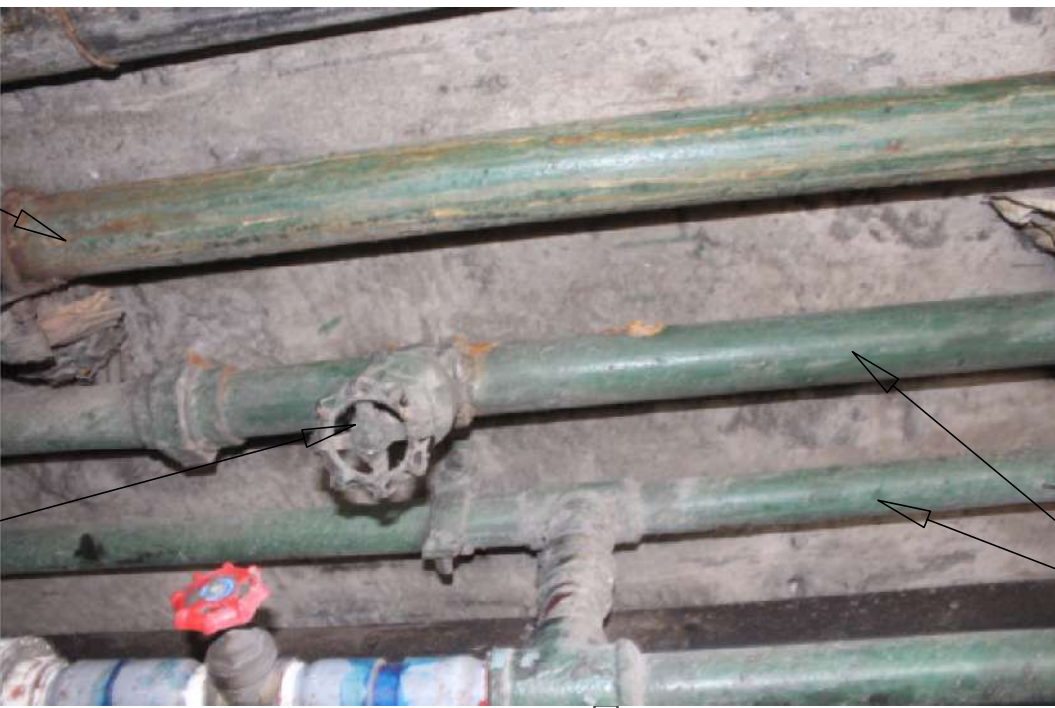
VALVULA DE CONTROL EN MAL ESTADO
