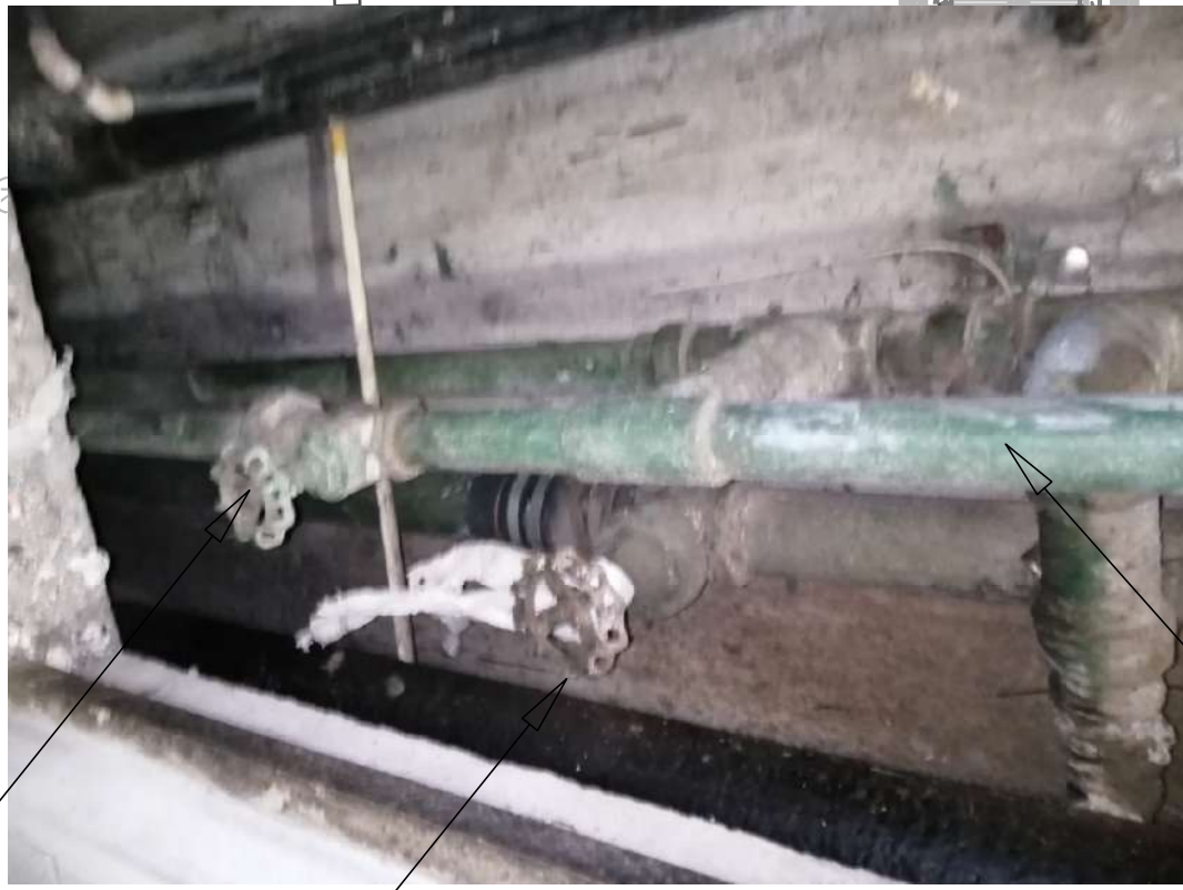
VALVULA DE CONTROL EN MAL ESTADO
