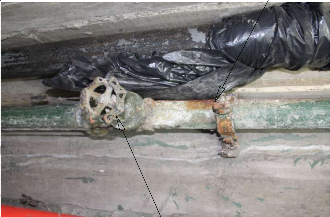
VALVULA DE CONTROL EN MAL ESTADO
