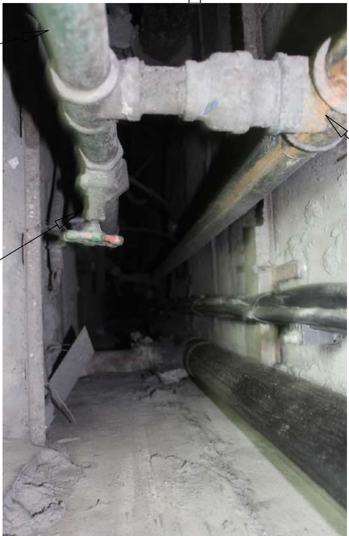
VALVULA DE CONTROL EN MAL ESTADO TRAMO EN FIERRO GALVANIZADO
