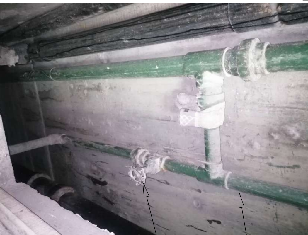
VALVULA DE CONTROL EN MAL ESTADO
