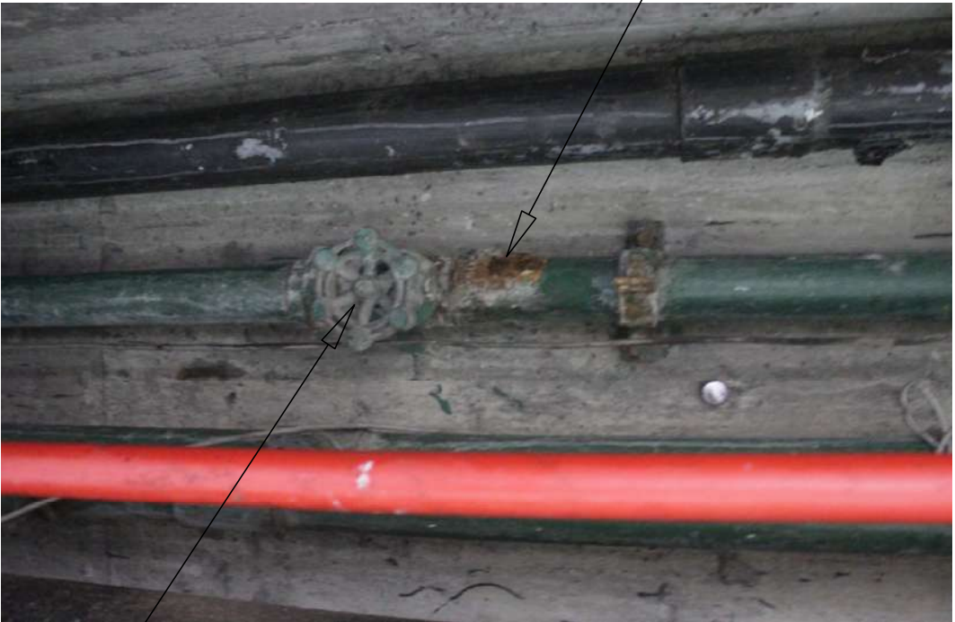
TRAMO EN FIERRO GALVANIZADO CON PRESENCIA DE CORROSION
