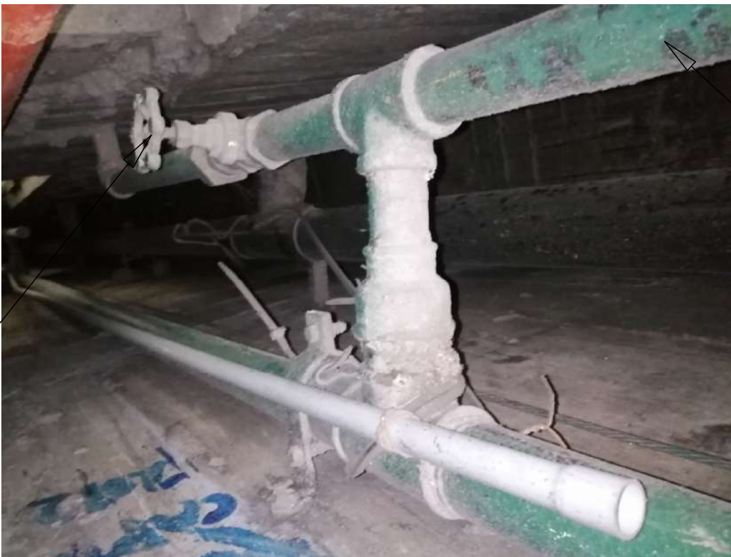
VALVULA DE CONTROL EN MAL ESTADO
