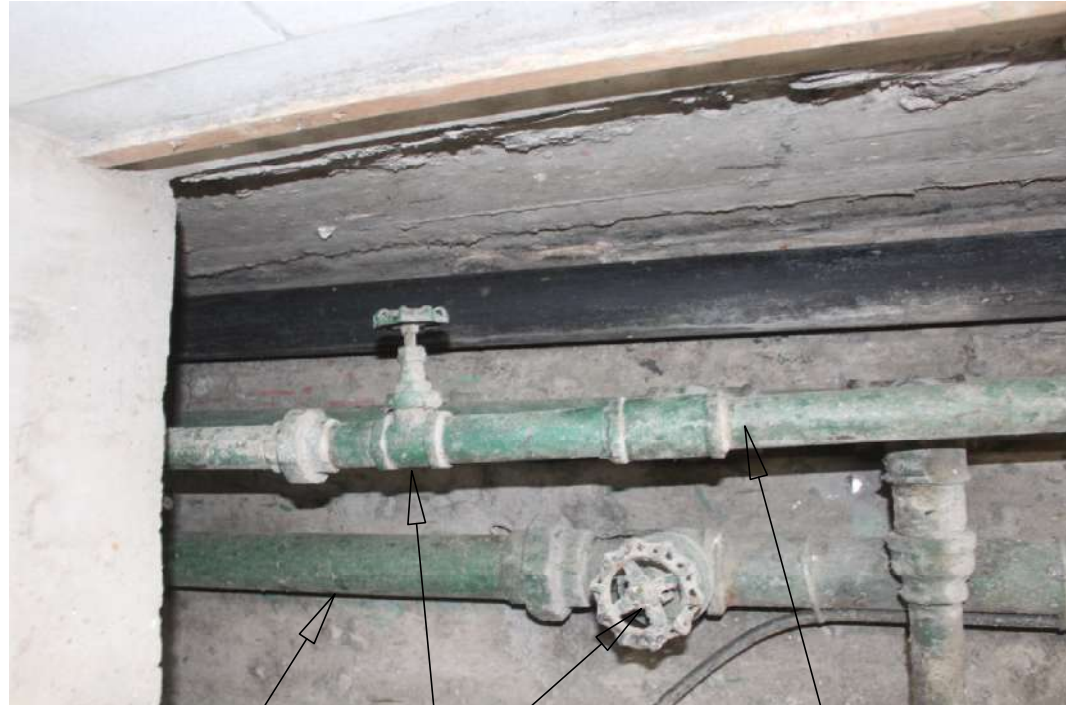
TRAMO REPARADO CON CHADERA DE PVC TRAMO EN FIERRO GALVANIZADO VALVULA DE CONTROL EN MAL ESTADO
