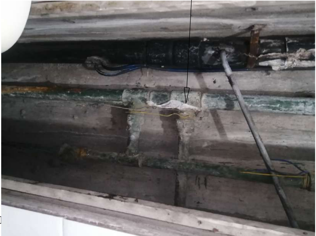
TRAMO EN FIERRO GALVANIZADO, CON PRESENCIA DE CORROSION
