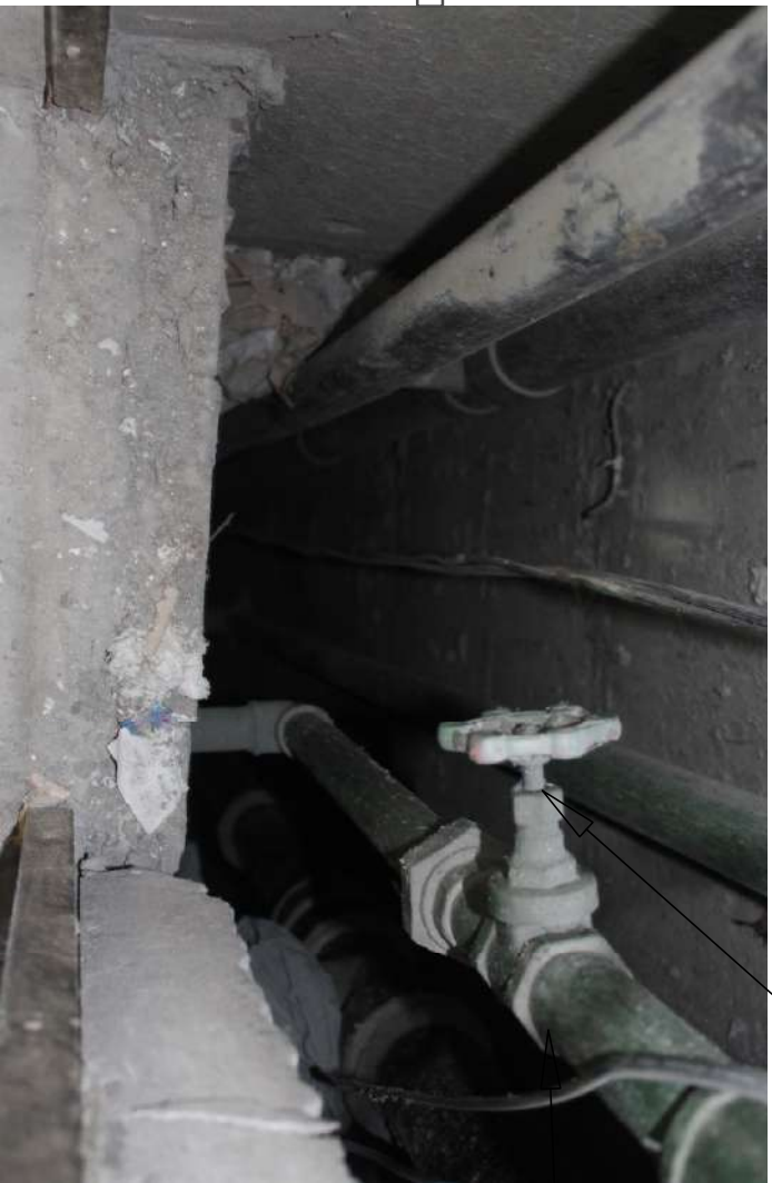
TRAMO EN FIERRO GALVANIZADO, CON PRESENCIA DE CORROSION
