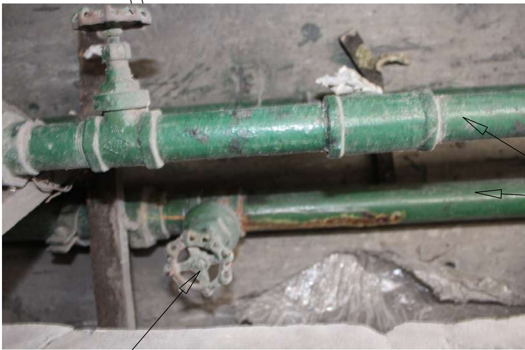
VALVULA DE CONTROL EN MAL ESTADO
