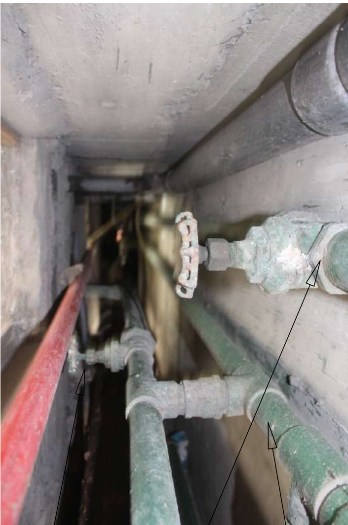
VALVULA DE CONTROL EN MAL ESTADO
