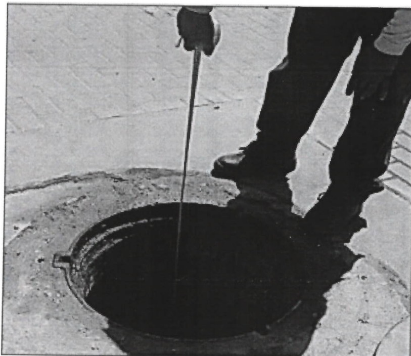
Ilustración 9: Buzones de concreto existentes, toma de profundidades.
