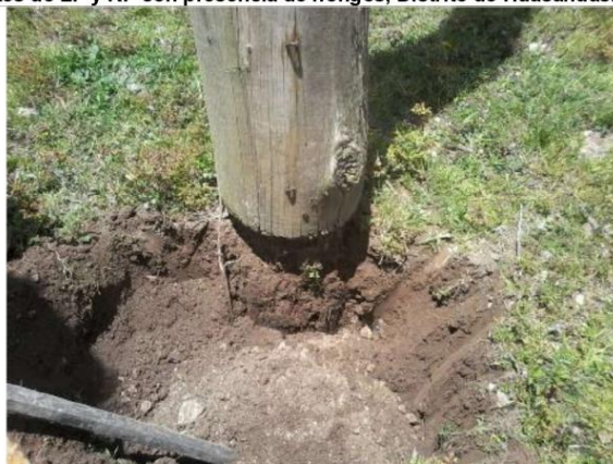
Postes con bases podridas que continuamente se desploman
