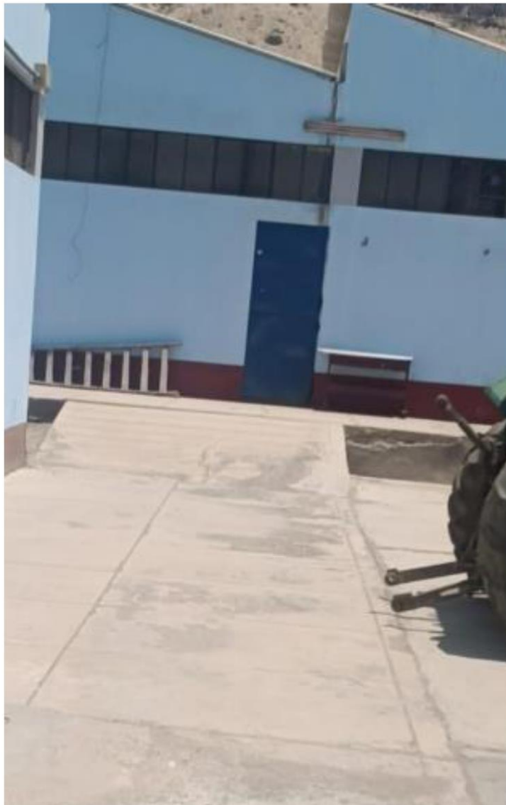
PENDIENTE DE RAMPA NO SE ADECUA A LA NORMA, DEMOLICION Y HABILITACION DE RAMPA
