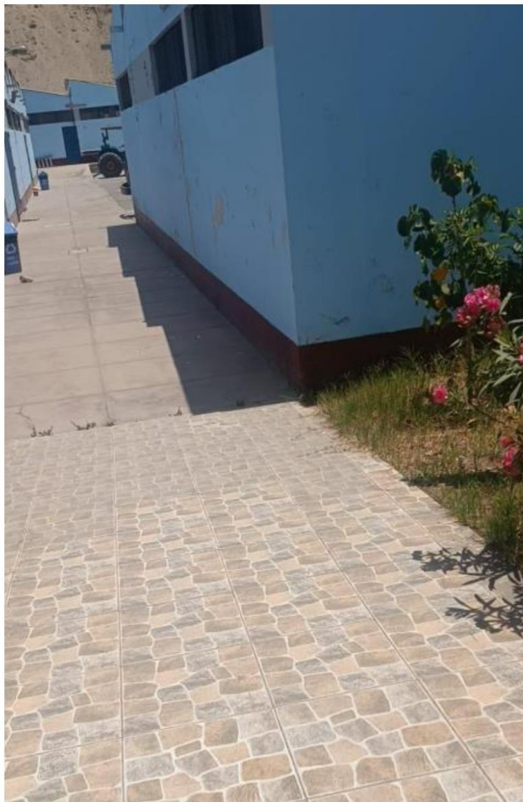
RAMPA DE CONEXIÓN A ZON DE NIVEL INFERIOR NO RESPETA LAS NORMAS, PENDIENTE NO ADECUADA
